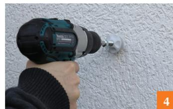
4. Wenn der Multi-Bit nicht vorliegt, die Stockschraube mit einem 25er Torx-Bit mindestens 40 mm, maximal 60 mm einschrauben. Die Abdeckrosette muss dicht aufliegen.
