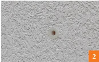
2. Den COBA-Thermodübel M10 bündig bis zum Putz einschrauben.
