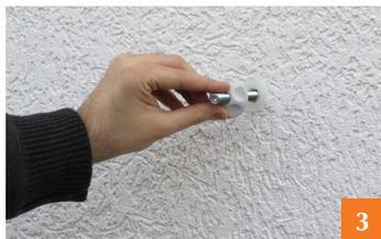
3. Die Stockschraube mit der vormontierten Abdeckrosette in dem COBA-Thermodübel M10 ansetzen.
