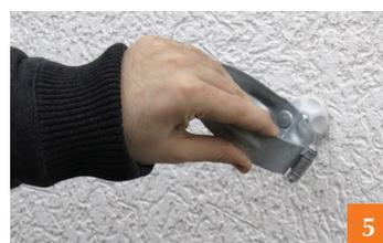
5. Abschließend die Rohrschelle mit dem M10-Gewinde aufschrauben.
