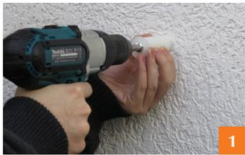
1. Die Eindrehhilfe in den Akku-Bohrschrauber einspannen und damit den COBA-Thermodübel M10 direkt durch den Putz in den Dämmstoff verankern.
