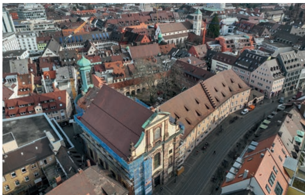
Die Unikirche Freiburg hat ein neues Dach erhalten und wurde mit Biberschwanzziegeln im Segmentschnitt eingedeckt.
