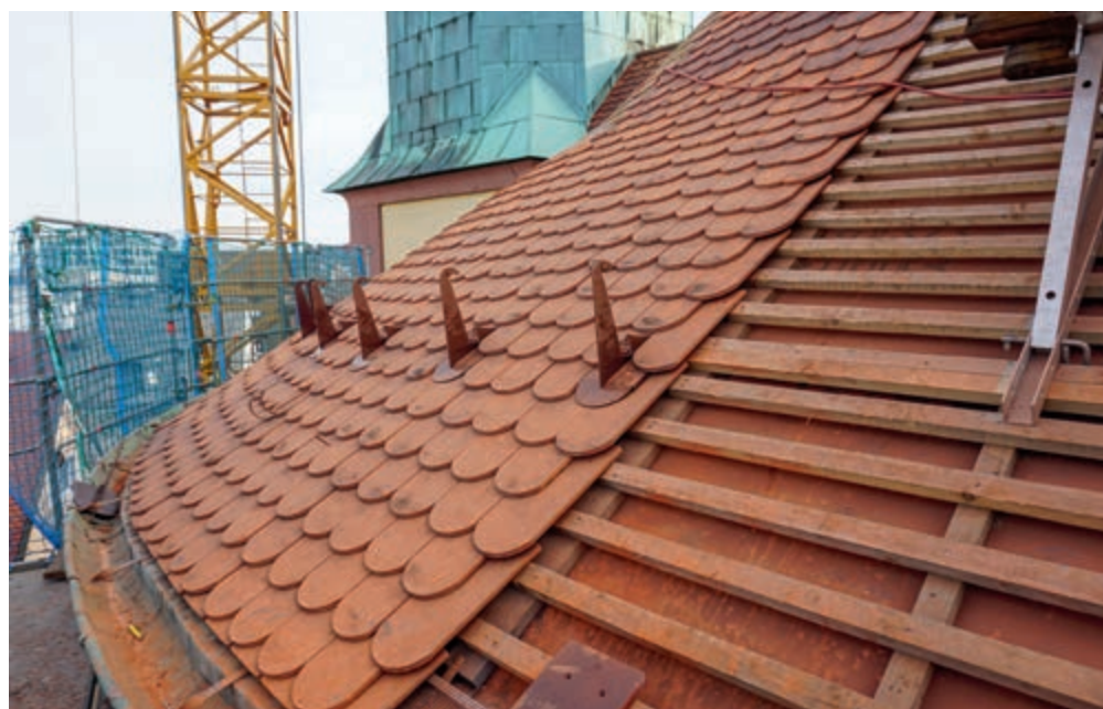
Die Schneelast wurde statisch berechnet und ein mehrreihiges Schneefangsystem mit Schneefanggittern als Sicherung installiert.
