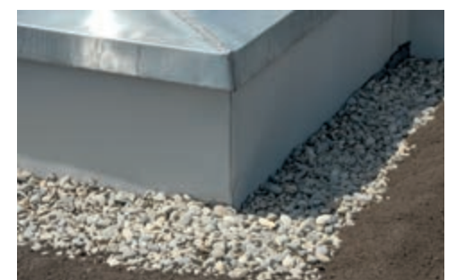
EverGuard an der Attika, Kiesbett als vegetationsfreier Streifen zwischen Attika und Substrat.
