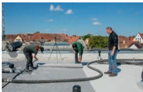
Abdichtung mit EverGuard TPO (rechts). Als erste Lage des Gründachaufbaus wird das Trenn- und Schutzvlies TSV 300 ausgerollt. Links Anja Karl.
