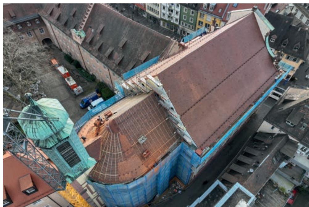
Das Umfeld bot nicht viel Platz zur Einrichtung der Baustelle.
