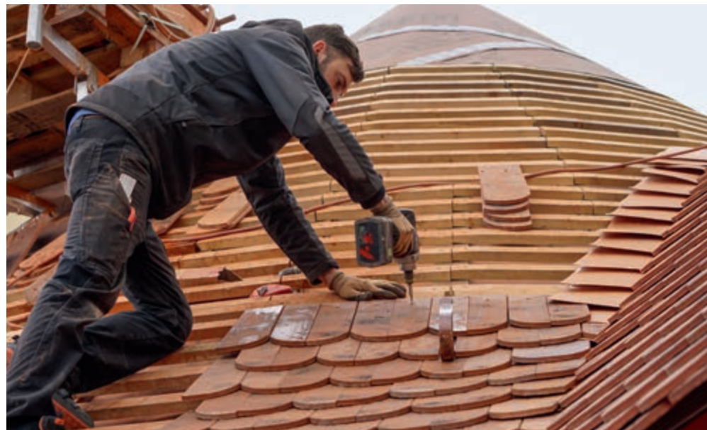
Im Gegensatz zu der Hauptdachfläche, gestaltete sich das Eindecken des halbrunden Chorraums recht anspruchsvoll.
