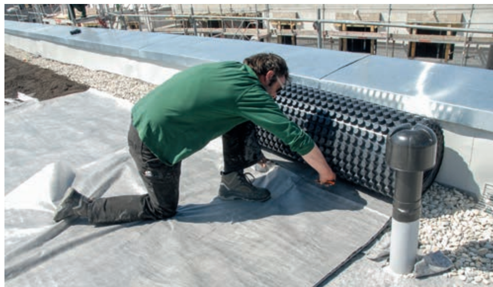
Zwei Arbeitsschritte in einem: Die Speicher- und Dränagematte Flor SD-V 25 wird von Dominik Burmann ausgerichtet und ausgerollt. Die Flor SD-V 25 Speicher- und Dränagematte lässt sich dabei einfach mit einem Messer zuschneiden.
