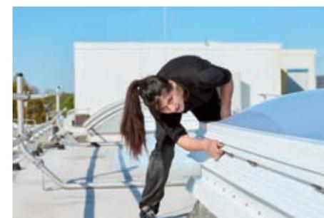
Schritt 4: Zum Schluss wird die Lichtkuppel auf dem Systemrahmen ausgerichtet und befestigt.
