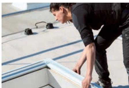
Schritt 2: Der Montagerahmen wird auf dem Aufsetzkranz ausgerichtet und mit der vorgesehenen Bohrung verschraubt.
