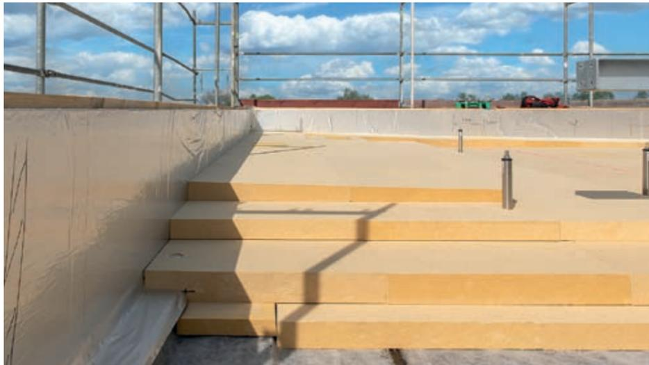
Die Dämmplatten werden nicht geklebt, sondern entweder mechanisch befestigt oder durch eine Auflast fixiert. © Fotos + Abb.: STEICO
