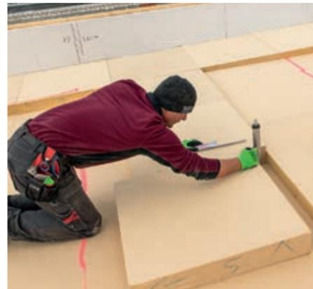
Weil die Gefälleebene projektbezogen vorkonfektioniert wird, sind die Dämmplatten einfach und schnell verlegbar.
