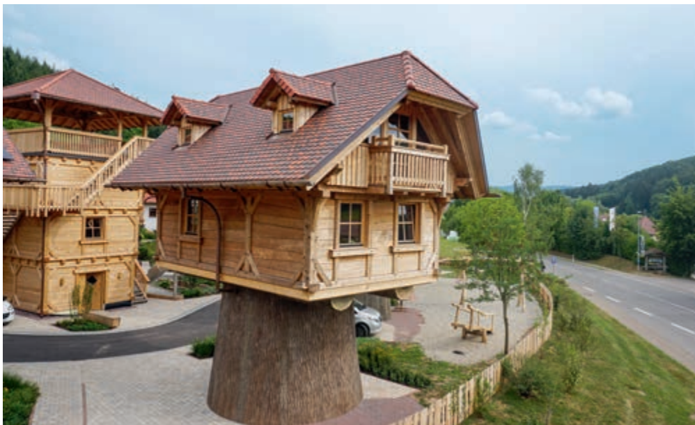
Die Häuser aus Holz sitzen auf einem „Stamm“ aus Beton.
