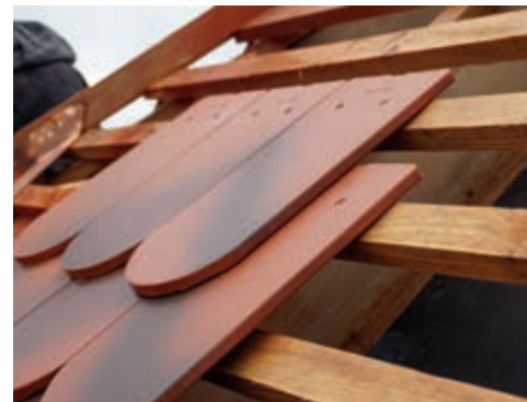
Die Biberschwanzziegel wurden in Doppeldeckung verlegt.
