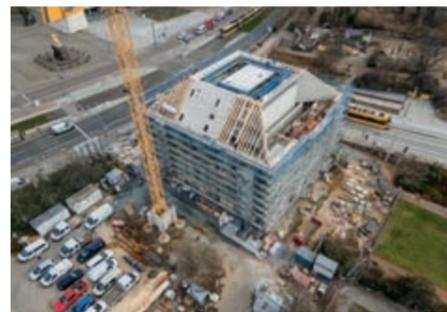
Für die Holzkonstruktion der Dachfläche wurden über 70 Kubikmeter Brettschichtholz und bis zu 11 Meter lange Sparren verarbeitet.
