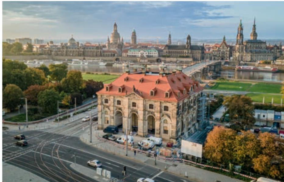
Die 1.061 Quadratmeter große Dachfläche des Dresdner Blockhauses erhielt eine Einfelddeckung mit „Profil Sächsische Biber“ mit profilierter Oberfläche in einem Sonderformat, die von Creaton in vier fein nuancierten Naturrot-/Kupferrot-Farbtönen produziert wurden.
