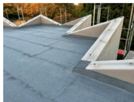
Die icopal Ventura Elastomerbitumen-Schweißbahn als Oberlage.
