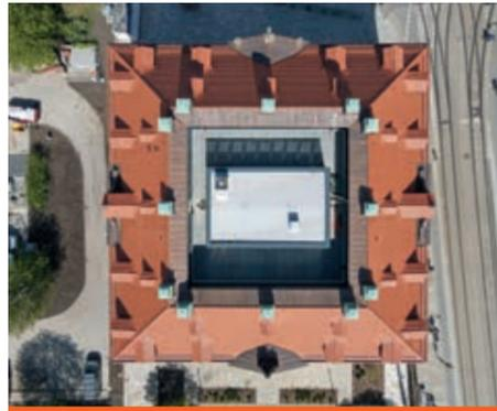
Der für die Aufnahme des Archivs der Avantgarden in das Gebäudeinnere eingefügte, massive Betonkubus endet 3,5 Meter unterhalb des Dachfirsts. Der Raum zwischen Lichthof und Dach wurde mit Dachbahnen aus FPO (flexiblen Polyolefine) abgedichtet. © Foto: Christoph Reichelt
