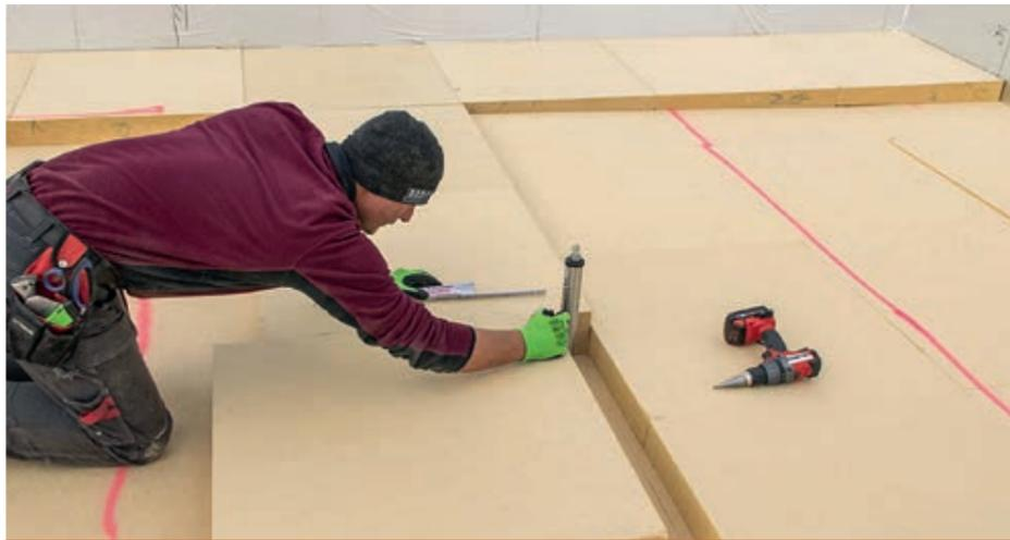
Die Gefälleebene des Holzfaser-Flachdach-Dämmsystems STEICRoof dry ist vorkonfektioniert und lässt sich einfach und schnell verlegen. © Foto: STEICO
