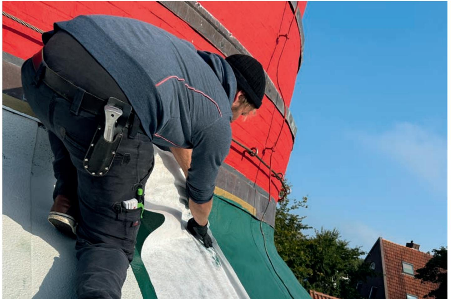
Ein Mitarbeiter der Firma Bochmann legt die Polyflexvliesbahn in die frische Einbettmasse aus Enkolan 1K LF ein.
