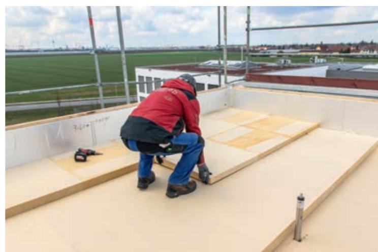
Die Dämmplatten werden nicht geklebt, sondern verlegt und am Ende mechanisch befestigt. © Foto: STEICO
