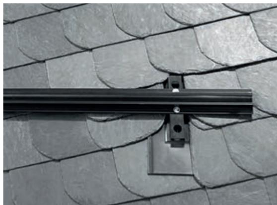
Die zugehörige Unterkonstruktion besteht aus Tragschienen, Eindeckblechen sowie Solarhaltern und ermöglicht die Befestigung der leistungsfähigen PV-Elemente.
