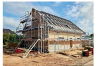
Direkt auf die Konterlatten über der Dämmung und Unterdeckbahn wurde bei diesem Zweifamilienhaus eine Tragkonstruktion für Indach-Solarmodule montiert.
