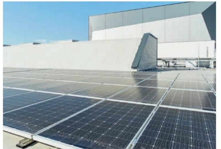
PV-Module werden häufig auf Tragsystemen montiert, die auf einem Flachdach unmittelbar auf die Dämmung und Abdichtung wirken. Lasten aus Eigengewicht und z. B. durch Schnee, der sich auf den PV-Modulen sammelt, werden konzentriert in den Dachaufbau eingeleitet. ROCKWOOL bietet mit „Solarrock“ eine sichere Lösung: Diese Dämmplatte zeigt auch längerfristig nahezu keine Verformung unter Tragkonstruktionen oder bei der Nutzung des Flachdaches als Terrasse.
