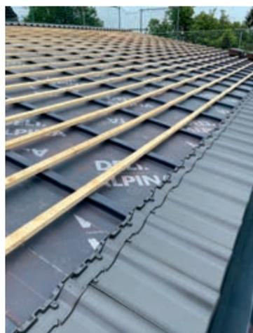
DELTA®-ALPINA ausgeführt als Klasse 1 mit DELTA®-ALPINA BAND für die Einbindung der Konterlatte.
