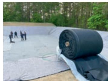
Ablage der EPDM-Abdichtungsplane vor der vorbereiteten Baugrube.
