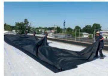
Direktsanierung auf PVC ohne vorherige Demontage und Entsorgung der Altabdichtung – möglich mit HERTALAN® EPDM-Planen und Induktionsverschweißung.
