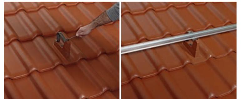
Nach Anschrauben des Modulstützenbügels auf die modellunabhängige Grundpfanne wird die Schiene aufgebracht.
