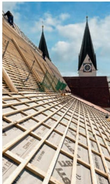
Die Dachkonstruktion ist klassisch aufgebaut: Unterspannbahn, Konterlattung, Traglattung.
