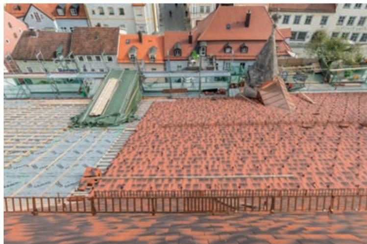
Im steileren Teil des Dachs ist ein Biberschwanzziegel verbaut, in den flacheren, unteren Bereichen ein Glattziegel.
