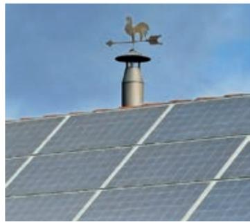
Aufdach-Photovoltaikanlage entbinden nicht von Windsogsicherung.
