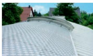
Das HDS-System gewährleistet nicht nur effizienten Sonnenschutz, sondern sichert das Oberlicht zusätzlich vor Schäden durch Hagel und sorgt für zuverlässige Durchsturzsicherheit. So bietet es mehr Sicherheit für auf dem Dach arbeitende Personen.
