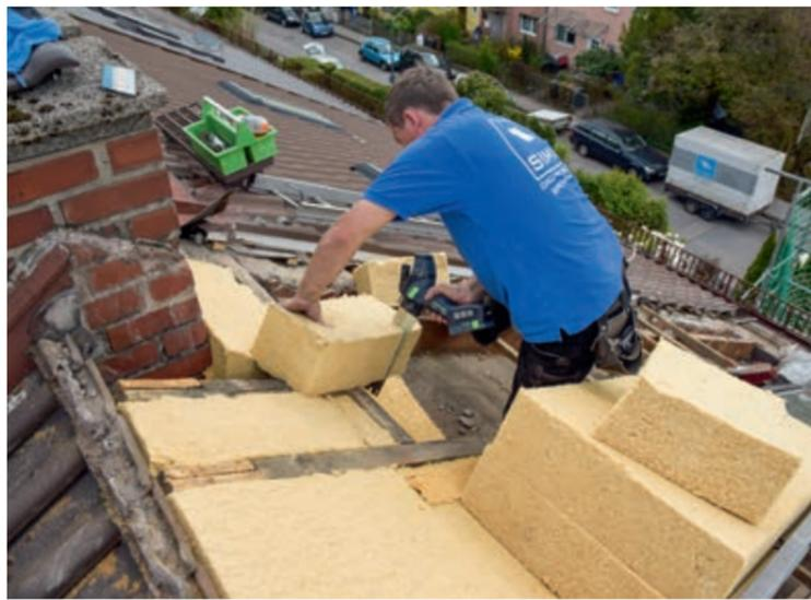
Dachmodernisierung ohne Dampfbremse.
