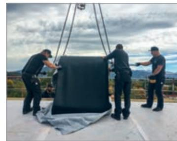
Die Abdichtung der neuen Holzunterkonstruktion wurde mit HERTALAN® EPDM-Planen ausgeführt. Diese wurden mit Hilfe eines Krans auf das Dach gebracht.
