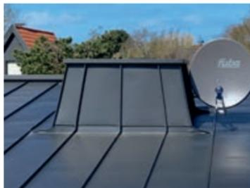
Durch die präzise Dacheinteilung fügt sich der konisch zulaufende Schornstein ohne optischen Bruch in das Linienbild der Dachwalze ein.
