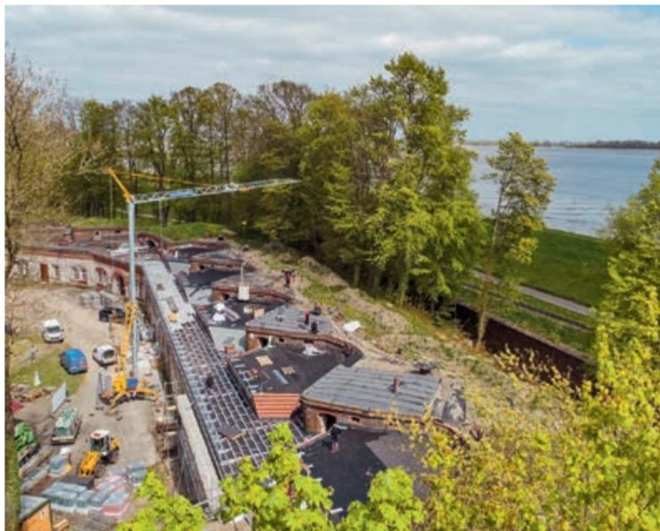
Die alte marode Dachpappe musste runter. Die Dachdecker der Gehrman Baugesellschaft verwendeten für das 600 m<sup>2</sup> große Dach der Festung Abdichtungsbahnen vom COBA-Vertragslieferanten Hasse & Sohn.
