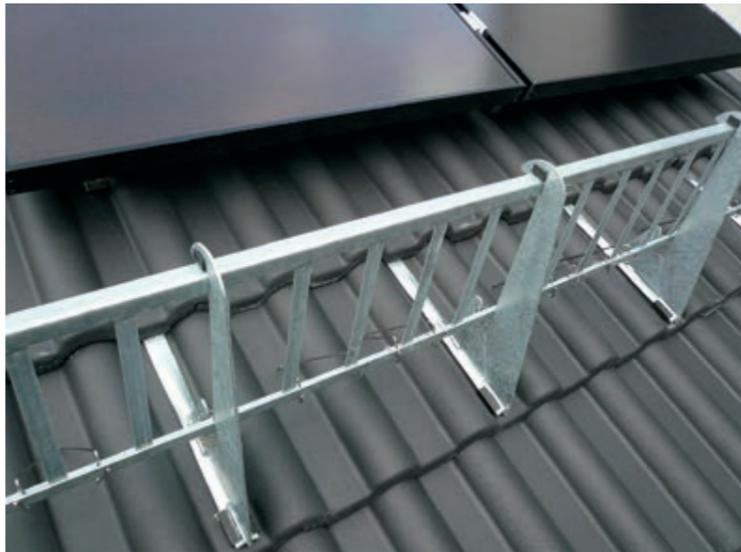
Schneefangsystem für Photovoltaikanlagen, 250 mm hoch.
