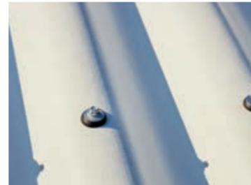
Die Befestigung der „Cembrit Wellplatten“ erfolgte an den längslaufenden Holzpfetten mittels Spezialschrauben mit Pilzkopf und integrierter Dichtung.
