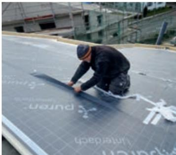
Aktivierung der Kleber-auf-Kleber-Verbindung in den Überlappungen.
