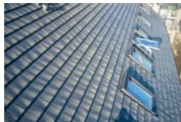
Besonderes Augenmerk lag auf dem Satteldach: Um in das Farbkonzept der Architekten zu passen, wurden die Ziegel mit einer speziellen Engobe sonderangefertigt.
