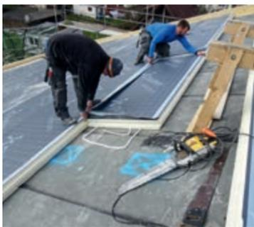
Verlegung der Dämmelemente puren Unterdach direkt auf der bituminösen Vordeckung. © Fotos: puren
