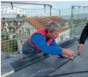
Wasserdichtes Einkleben der Traufelemente.
