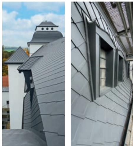
Die Falz-in-Falz-Verlegetechnik der PREFA Dachsysteme ermöglichte eine einfache Verarbeitung.
