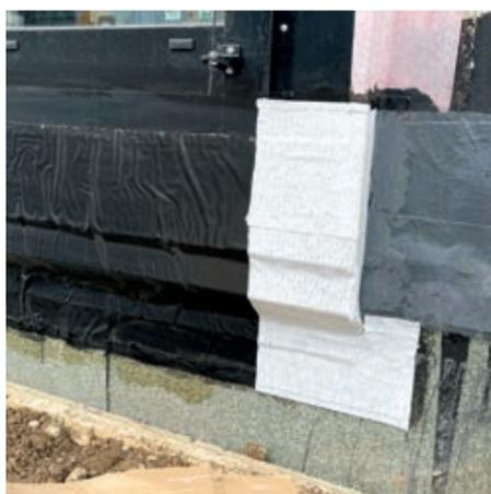
MOGAT LIQUID MAB+: Das selbstklebende Multianschlussband als Haftbrücke für alle glatten Untergründe, hier Kunststoff und HDPE-Trägerfolie.
