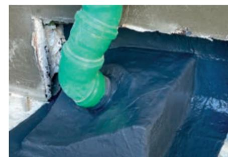
MOGAT LIQUID SOLO 1K – der einkomponentige Flüssigkunststoff für komplexe Anschlüsse und Detailausbildungen, hier Anschluss an PE.
