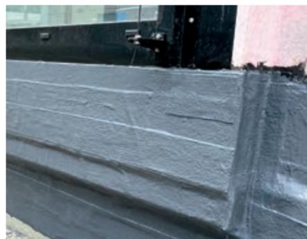
Ein sicherer Verschluss: Dank seiner hohen Viskosität eignet sich MOGAT LIQUID MAB+ optimal für Applikationen in der Senkrechten.
