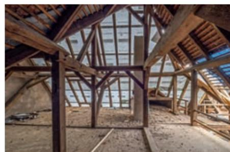
Leichte PU-Dämmung ermöglichte den Erhalt des originalen Dachstuhls.
