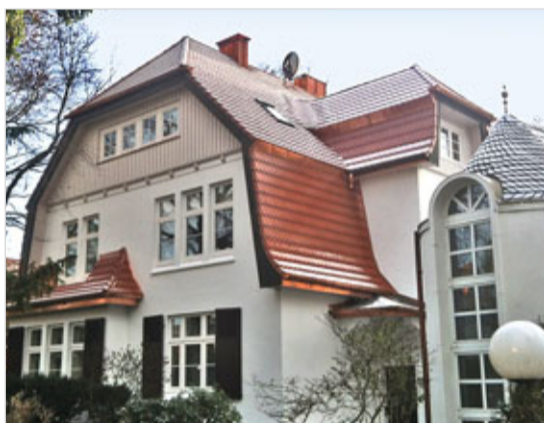
Alter Charme – modern saniert: das Dach dieser Hamburger Jugendstilvilla modernisierte die Dachdeckerei Dittmer nach neuesten energetischen Gesichtspunkten.
