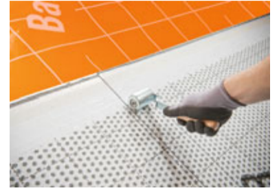
Überlappungen ausrichten und durch Andrücken fixieren. „Masse-in-Masse“-Verklebung mit Andrückrolle aktivieren.
