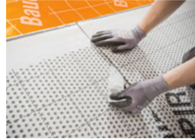
Beide Abziehfolien der Vertikalüberlappung gleichzeitig herausziehen.
