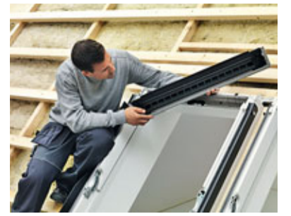
Die Montage von VELUX Balanced Ventilation: Austausch des Standard-Markisenkastens.
