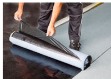
Mit der Kaltselfstklebetechnik ist eine Einsparung der Verlegezeit von bis zu 50 % möglich.
