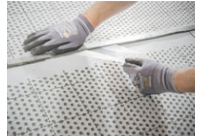
Beide Abziehfolien der Horizontalüberlappung gleichzeitig herausziehen.
