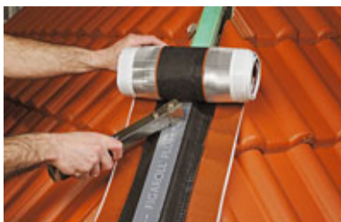
Die Seitenstreifen aus beschichtetem Aluminium machen Figaroll Plus unempfindlich gegenüber Verschmutzung und extrem UV-beständig.
