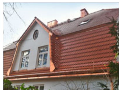
Glasierte Biber in Kronendeckung, eingebundene Kehlen und Kupferblech geben dem Dach eine hochwertige Optik.
