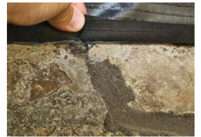
Eine 4 mm dicke Kleberaupe sichert die solide Verklebung der Luftdichtheitsebene auf dem Bruchsteinmauerwerk.
