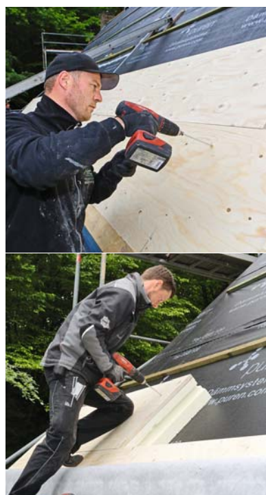
Nut-Feder-System stirnseitig und Stufenfalz längsseits erleichtern eine professionelle Verarbeitung.
