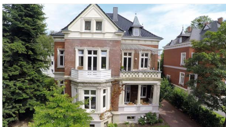
Meisterhaft bedacht: mit dem Flachdachziegel Nibra F10Ü von Nelskamp wurde ein robuster und formschöner Ziegel eingesetzt.
