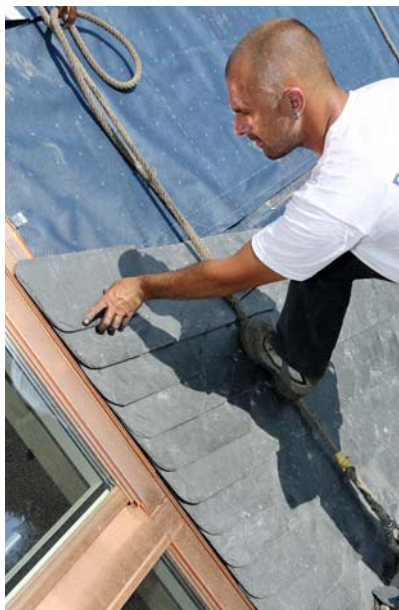
Starkes Gespann: ästhetische und langlebige Schieferdeckung auf einer Passivhausdämmung.
