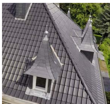
Die kleinen Türme erfreuen sich jetzt einer neuen Haube aus Naturschiefer. Sie wurden exakt so wieder eingedeckt, wie der Denkmalschutz es gefordert hatte.
