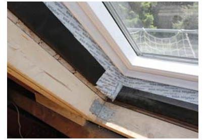
Sorgfältige Verklebung der Luftdichtheitsebene mit dem Dachfenster.
