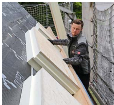
Elementverlegung oberhalb der exakt ausgerichteten Traufbohle.
