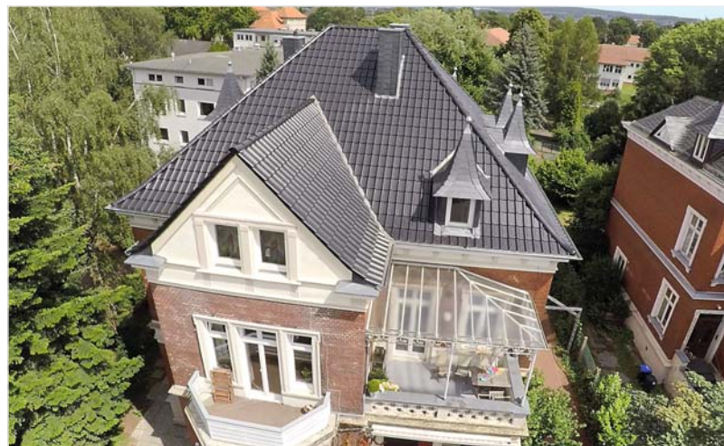
Das Dach des wunderschönen alten Backsteinbaus in der Lülingstraße in Bückeburg präsentiert sich nun in neuem Glanz.
