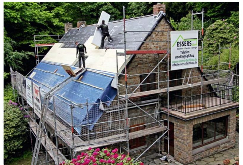
Anders sein als die anderen: Dachbau mit System und Qualitätsanspruch.
