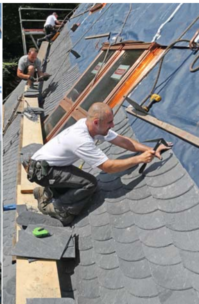
Starkes Gespann: ästhetische und langlebige Schieferdeckung auf einer Passivhausdämmung.
