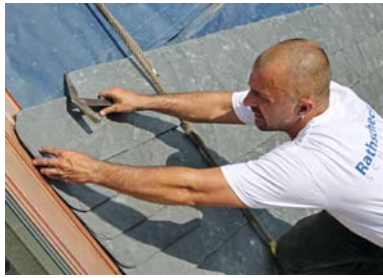
Eingebundene Dachfenster und Kupfer-Eindeckrahmen.
