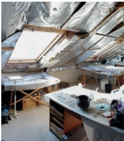
Vor und nach der Renovierung.
