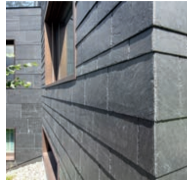
Perfekt eingekemmt: An den Ecken sind die Schiefer exakt angearbeitet.
