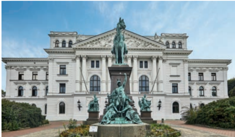
Die Oberlichter auf dem denkmalgeschützten Rathaus in Hamburg-Altona wiesen altersbedingt und aufgrund starker Umwelteinflüsse erhebliche Schäden wie Risse auf, die zu Undichtigkeiten führten. Zudem wurde auch ihre Lichtdurchlässigkeit durch Verfärbungen negativ beeinträchtigt.
