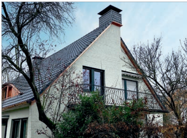
60 Meter Kupferinne brachten die Dachhandwerker rund um das Haus an, die im Zusammenspiel mit den anthrazitfarbenen Hohlfalzziegeln und den weiß gestrichenen Klinkern einen schönen Kontrast bildet. Nach einiger Zeit bildet das Kupfer eine natürliche matte Patina.
