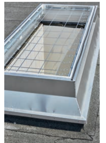
Mit der Ab- und Durchsturzsicherung entschied man sich für ein geprüftes und zertifiziertes System, das die Primärforderung der Arbeitsschutzrichtlinie A2.1 erfüllt und dauerhafte Sicherheit bietet.
