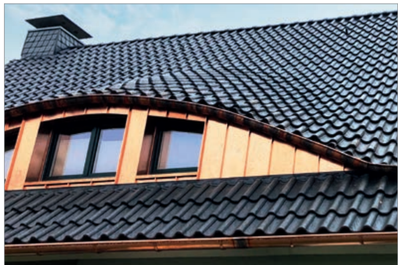
Die Fledermausgaube verleiht dem Dach die weiche, elegante Linie, die durch die mit Kupfer ausgeführten Klempnerarbeiten noch zusätzlich betont wird.
