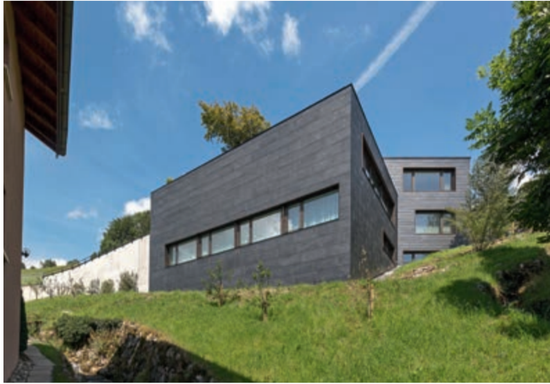
Monolith aus Symmetrischer Deckung mit 120 x 50 cm großen Schieferplatten.
