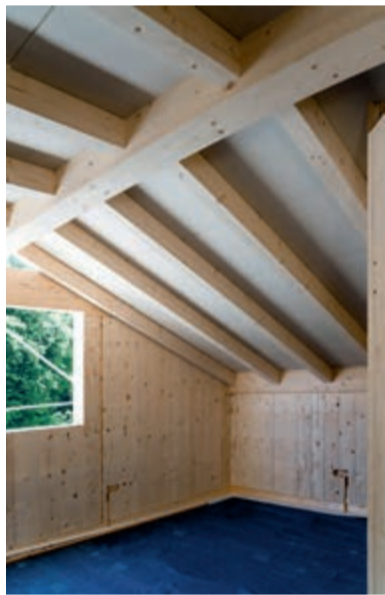
Elegante Untersichten aus gehobelten Holzsparren werden durch leistungsfähige Dämmungen über den Sparren möglich. © Fotos: puren
