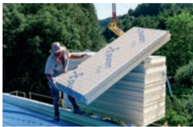
Bereits eine 160 mm dicke PU-Dämmung, über den Sparren verlegt, erfüllt neueste Standards.
