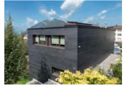
Zur Bergstraße hin krümmt sich die Wand und erzeugt einen edlen seidigen Glanz.
