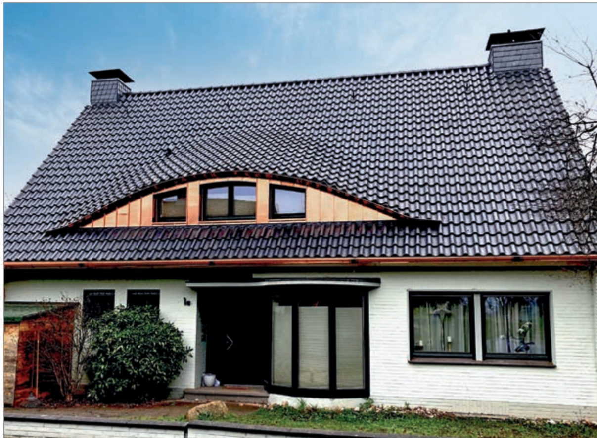
Für die Sanierungsarbeiten am Dach des Einfamilienhauses benutzte das Team von Sieberg Bedachungen den einfachverfalzten Spezialziegel Z5 von Jacobi Walther, der ein variables Deckspiel mittels gedrückter und gezogener Verlegung ermöglicht. Alle Materialien lieferte die Anton Gallhöfer GmbH aus Oberhausen.
