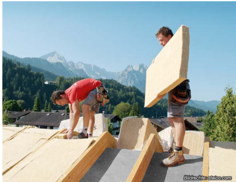
STEICOflex: Einsatz am Dach als flexibler Dämmstoff in den Gefachen
