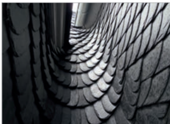
Die Herausforderung steckte im Detail. Beim neuen Naturschieferdach (Rathscheck) sieht man die meisterhafte Verarbeitung unter anderem in den Kehlen und Gauben. Die Dachdecker Günter Ackermann, Ralf Kirstges und Gunter Heilmann von der Dachdeckerei Werner Risch arbeiteten hier mit einer sehr großen Präzision und einem Höchstmaß an Handwerkskunst.
