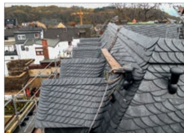
Die Herausforderung steckte im Detail. Beim neuen Naturschieferdach (Rathscheck) sieht man die meisterhafte Verarbeitung unter anderem in den Kehlen und Gauben. Die Dachdecker Günter Ackermann, Ralf Kirstges und Gunter Heilmann von der Dachdeckerei Werner Risch arbeiteten hier mit einer sehr großen Präzision und einem Höchstmaß an Handwerkskunst.
