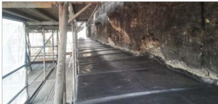
Gerade bei diesem Bauwerk stellte auch der Anschluss zum Mauerwerk eine Herausforderung dar. So musste die Vorderkante der historisch bedingten Linienführung folgen.
