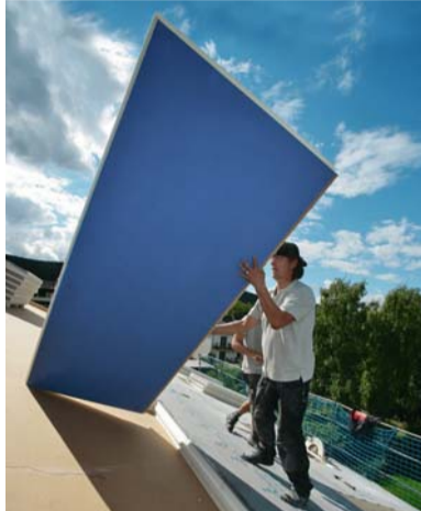
Ein großer Einsatzschwerpunkt für PU-Dämmstoffe ist das geneigte Dach.
