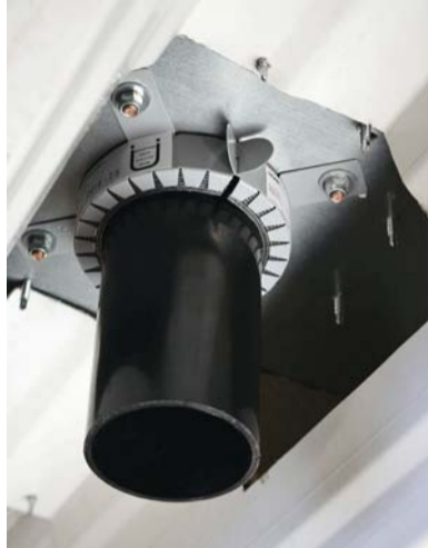
Rundum-Schutz fürs Fallrohr: Die SitaFireguard® Brandschutzmanschette.
