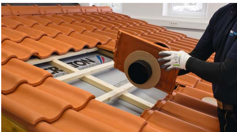
Der universelle Unterdach-Anschlussadapter ist für unterschiedliche Durchdringungen bis zu einem Durchmesser von 200 mm geeignet. Fotos: Creaton
