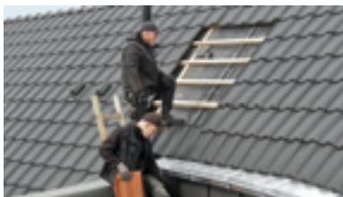
Rundverlegung im Innenbogen.
