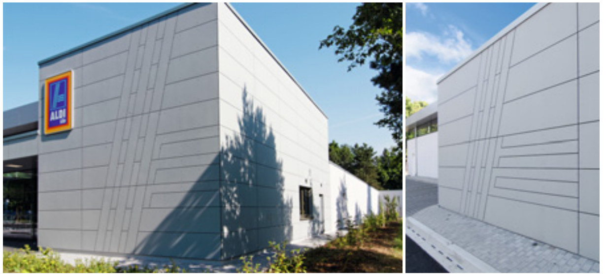
Nach dem Plan des Handwerkers hatte die Mörk KG die Plattenrohlinge auf der hauseigenen CNC-Anlage entsprechend gefräst und gebohrt. Die einheitliche Fassade besteht aus zwei Fassadenteilen, die mit lebhaften Intarsien aufgelockert wurden – so schön kann Grau sein!
