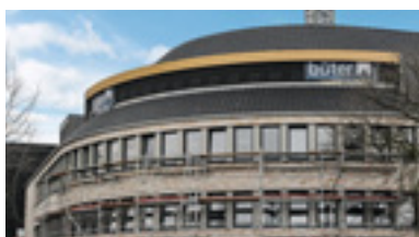
Fertiger Außenbogen: harmonischer Viertelkegel mit Dachgaube.
