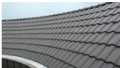
Fertiger Innenbogen: Dachfläche ohne Grate und Kehlen.
