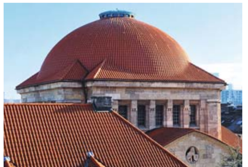
Das anspruchsvolle Kuppeldach in Mönch- und Nonnendeckung ist unten eckig und oben rund.
