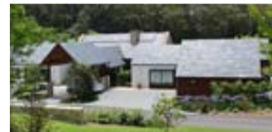
Mit der Rathscheck-Systemdeckung sind selbst große Dachflächen schnell eingedeckt.
