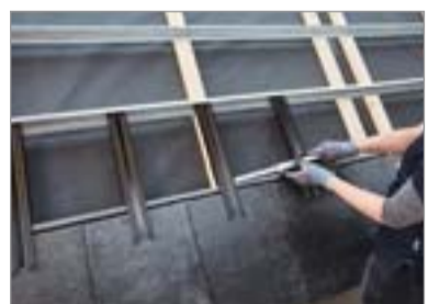
Anordnen der Verbinder im halben Verband.
