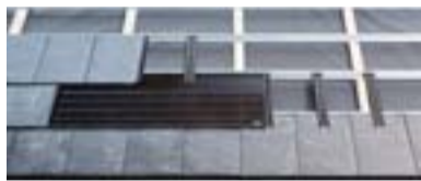
Blick auf eine Rathscheck-Systemdeckung mit Schiefen und Photovoltaik-element.
