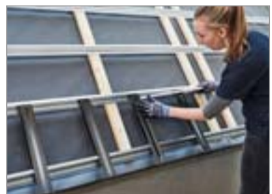
Einmessen der wasserführenden Verbindungselemente.
