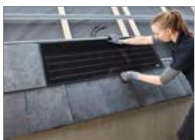
Das passende Rathscheck-Solar-modul wird analog der Schiefer in das vorhandene System eingehängt.
