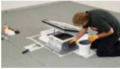
BauderLIQUITEC – das Flüssigkunststoff-Abdichtungssystem für komplexere Durchdringungen und Details auf dem Flachdach.
