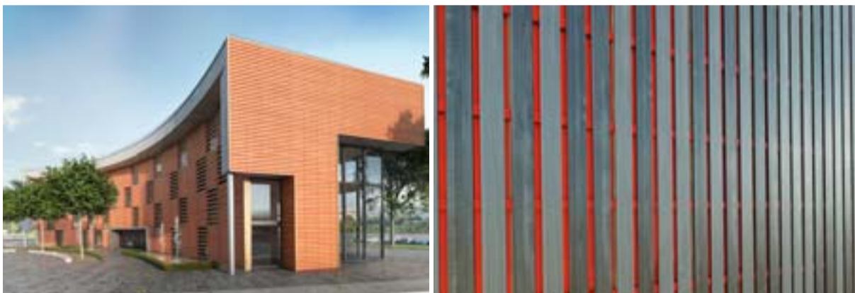
Im Zusammenspiel mit den offenen Fugen einer Holzfassade kommt die farbige Fassadenbahn voll zur Geltung – ganz gleich, ob die Latten vertikal oder horizontal verlaufen. Die Fassade erhält dabei – im wahrsten Sinne des Wortes – mehr „Tiefe“.
