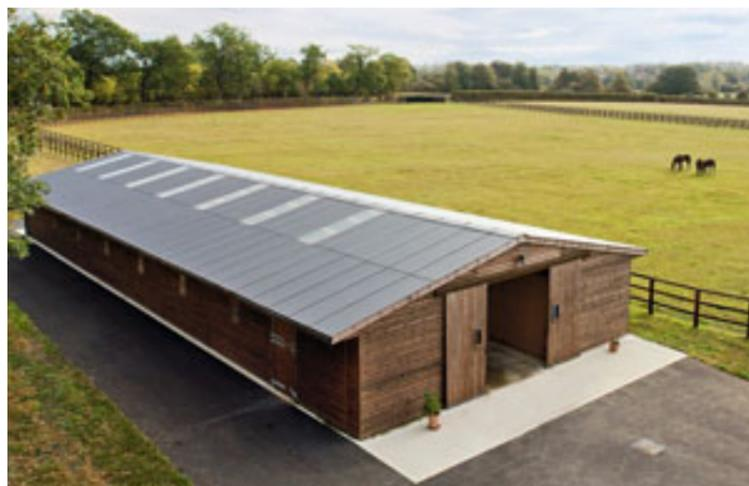
*CEMBRIT Faserzement-Wellplatten bieten ein hohes Maß an Sicherheit und Wirtschaftlichkeit. Die Geräusentwicklung im Gebäude bei Regen und Hagel wird mit dem Einsatz dieser Wellplatten im Vergleich zu einem Dach mit Metalleindeckung minimiert, was gerade in der Tierhaltung von Bedeutung ist.*
