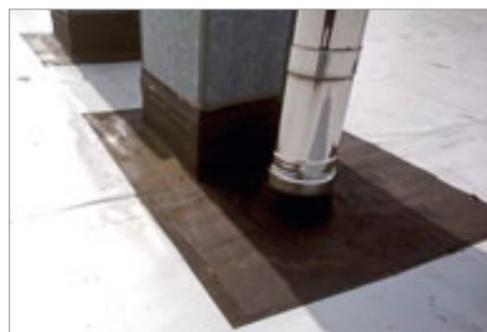
Lüfteranschlüsse mit Flüssigkunststoff in Vlieseinlage.
