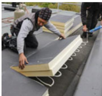
Schwer entflammable Dämmstoffe von puren gibt es nach neuer DIN EN 13501 bis zur Class B-s1.
