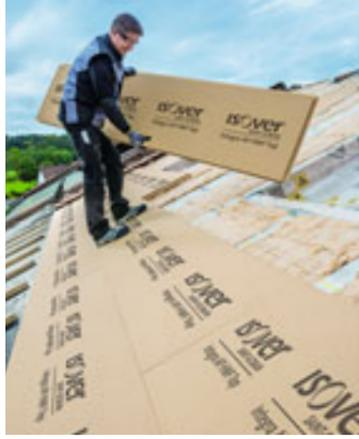
HWF Top Aufsparren-Dämmplatte im direkten Vergleich zu anderen im Markt befindlichen Holzweichfaserplatten durch hohe Rutschfestigkeit überzeugt. Damit bietet ISOVER höchste Arbeitssicherheit bei Begehung der Platte im Bereich der Sparren – und zwar sowohl im trockenen wie auch im nassen Zustand.
