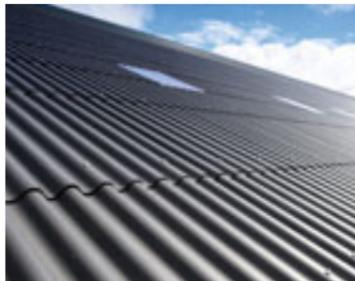
*CEMBRIT-Wellplatten sind in sechs Farben lieferbar. Vier Längen und zwei Breiten gestatten eine wirtschaftliche Planung der Dachdeckung. Sie sind frost- und korrosionsbeständig, diffusionsoffen, pilz- und schimmelresistent.*
