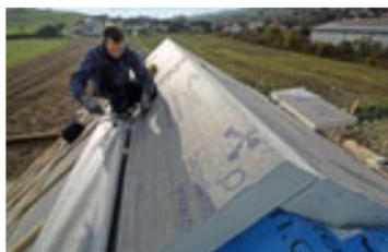
Effiziente Aufsparrendämmungen mit hochwertigen Unterdeckbahnen trotzen im Notfall auch Schlagregen und Hagel. Fotos: puren
