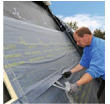
Mit PUR Unterdach von puren sind auch wasserdichte Unterdächer möglich.
