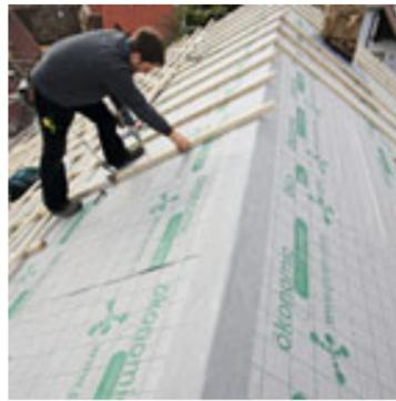
Eine effiziente Wärmedämmung und dazu eine robuste Unterdeckung bietet das Aufsparrendämmsystem ökonomisch von puren.
