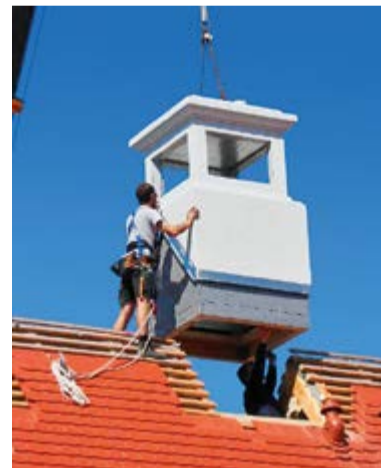
Millimetergenaues Einpassen der vorgefertigten Zierschornsteine mittels Autokran auf die vorbereiteten statischen Montagesockel im Dach.
