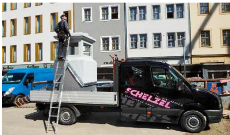
Transport der fertigen Zierschornsteine an die Baustelle. Gut zu sehen sind die filigranen Metallarbeiten und perfekten Anpassungen an die historischen Profile mit ENKE-Produkten. Fotos: Enke
