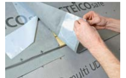
Dank integrierter Selbstklebestreifen können sämtliche Stoßfugen (vertikal und horizontal) einfach und schnell miteinander gefügt werden.
