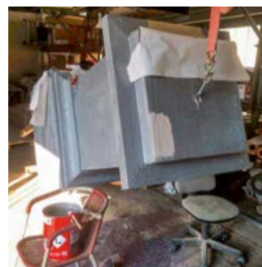
Herstellung der Zierschornsteine mit Enkepur, Vlies, Enketop und Quarzsand.
