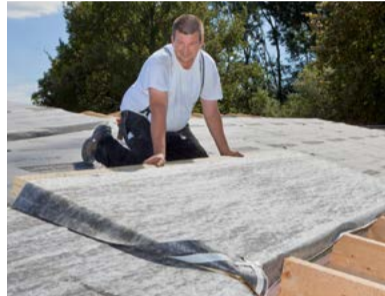
LINITHERM PAL SIL T mit LINITHERM PAL N+F Platten als zweite Entwässerungsebene. In Kombination wird bei einer Dämmstoffstärke von insgesamt 66 + 100 mm ein U-Wert von 0,14 W/m 2 K erreicht.
