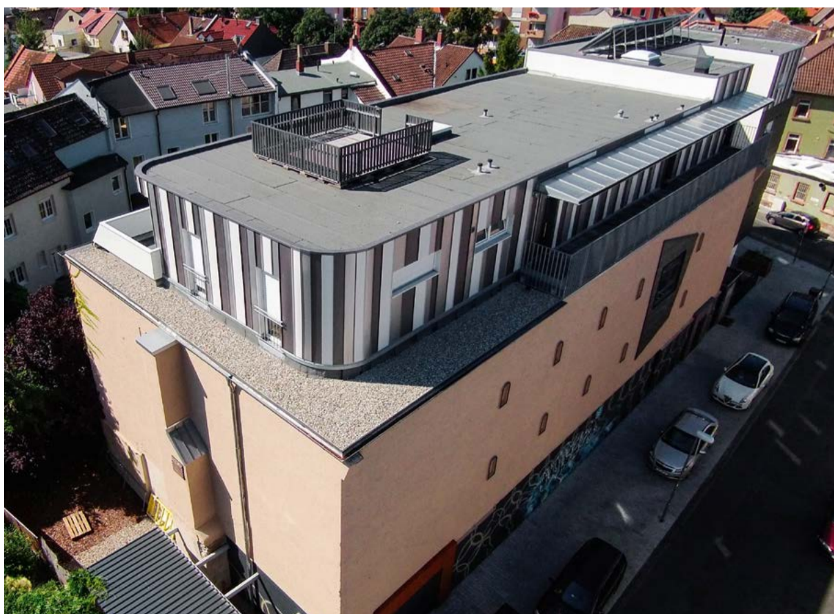
Nach der Sanierung des Bunkers sind auf 590 Quadratmetern vier Miet- und zwei Penthouse-Wohnungen entstanden.
