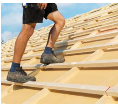
Die maschinelle Dachlattensortierung garantiert Durchtrittssicherheit und feste Standards.
