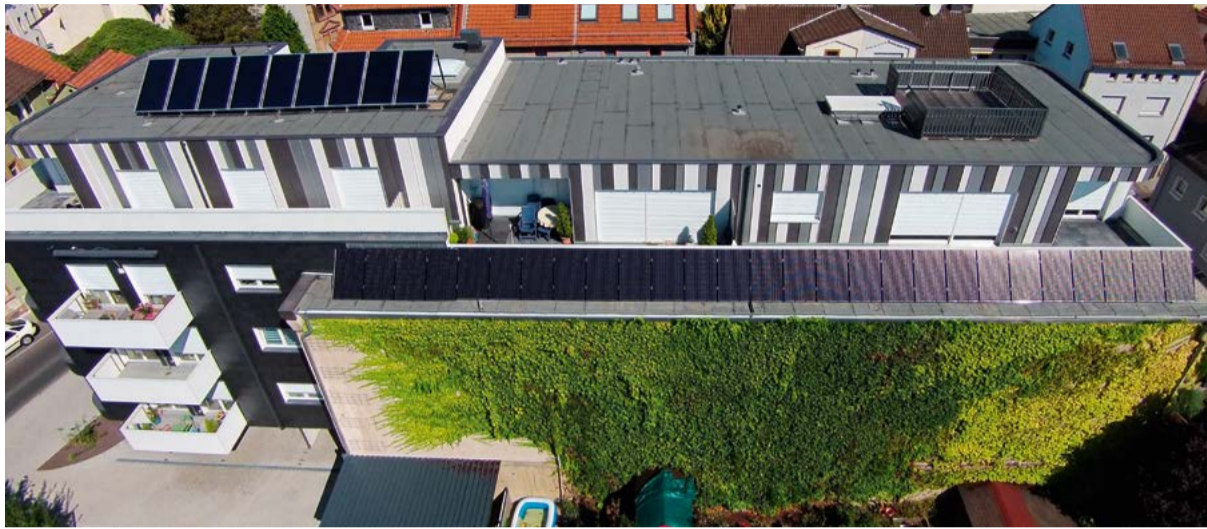
Die Rückansicht des ehemaligen Bunkers. Links ist der Anbau zu sehen. Die anspruchsvolle Fassade der Penthouse-Wohnungen auf dem Dach wurde mit dreifarbigem Falzstahl präzise umgesetzt.
