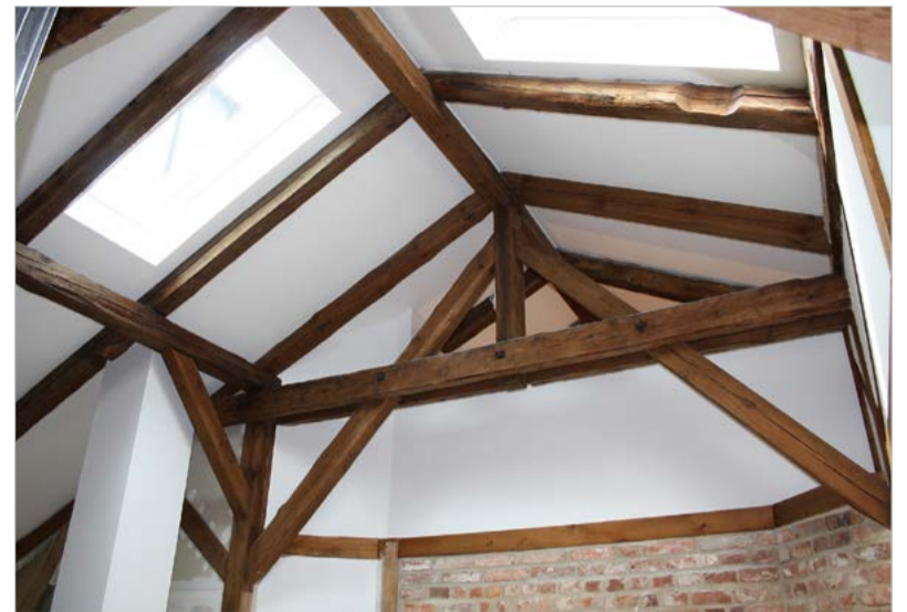
Die weiß verputzten LINITHERM PAL SIL T Dachuntersichten setzen die Dachbalken optisch besonders schön in Szene.
