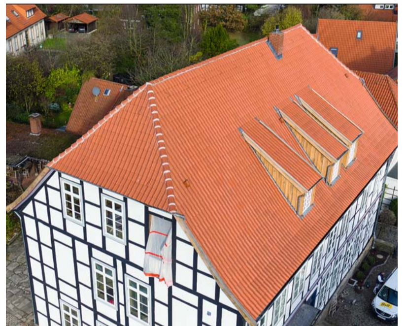
Die Gauben wurden wie die Stirnbretter mit rohen Eichenbrettern bekleidet. Fotos: Braas
