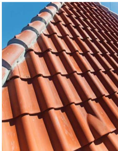
Die Lüfterziegel sind sehr dezent in das Deckbild integriert. Die Grate und Firste wurden nach den Anforderungen der Denkmalpflege vermörtelt.
