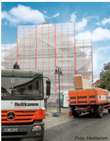
Ein starker Partner für den Dachdecker: Der COBA-Fachhändler Heitkamm in Osnabrück lieferte die Materialien zur Baustelle der Alten Apotheke in Bad Essen.
