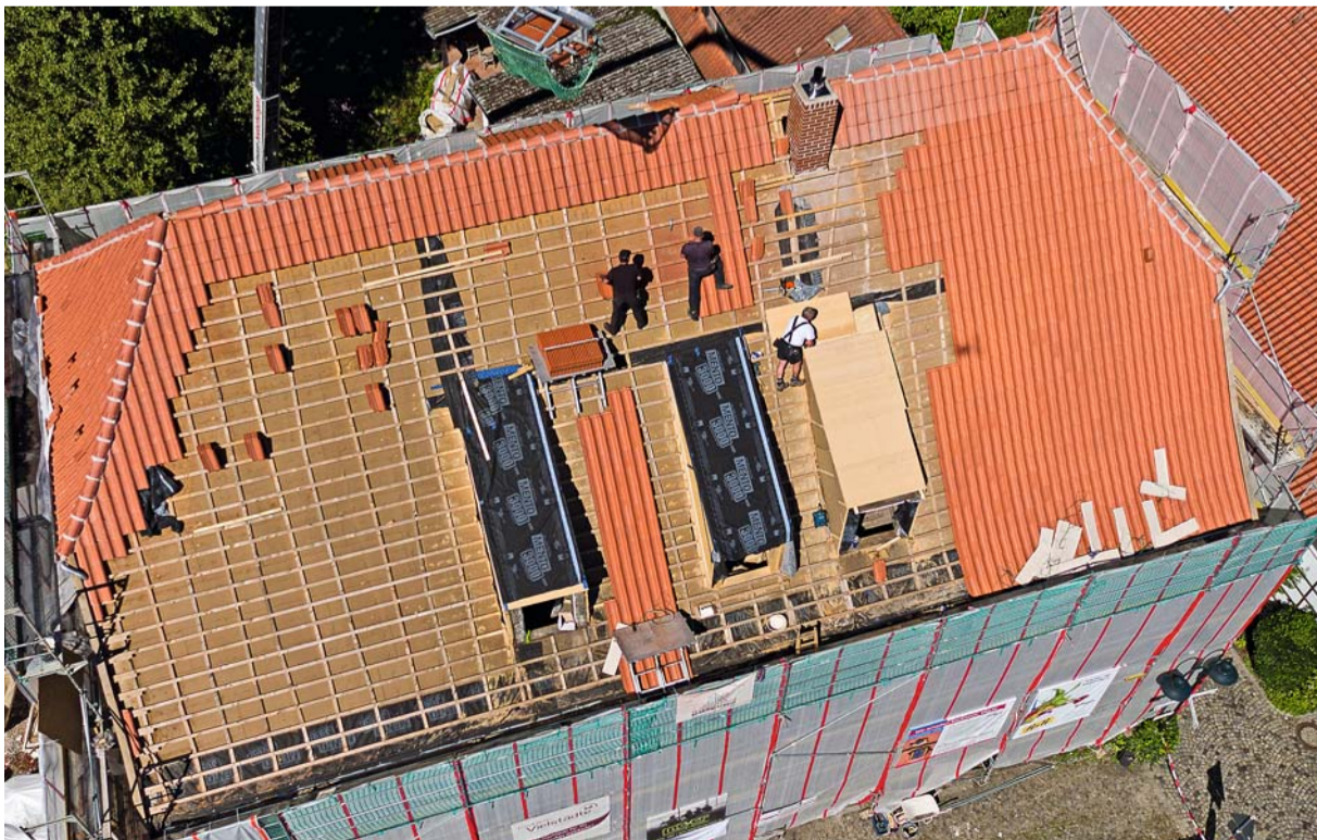
Dachdecker und Zimmerer arbeiten „Hand in Hand“ über den Dächern von Bad Essen.
