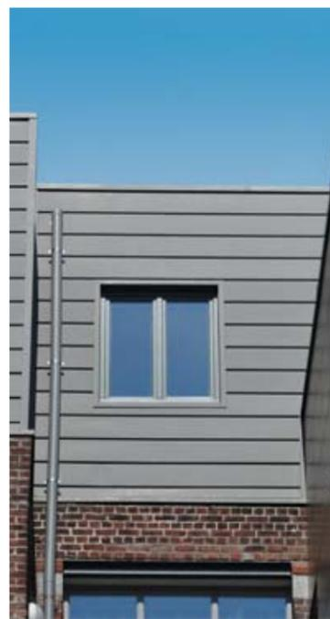
VMZ Unicprofil lässt sich mit allen Fassadensystemen von VMZINC kombinieren. Das einfach zu installierende Profilsystem eignet sich jedoch auch für andere Fassadenbekleidungen.
