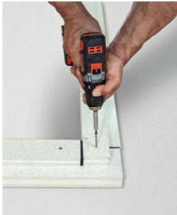
Arbeitsschritte wie Abmessen, Sägen oder Zuschneiden entfallen dank des Dämm- und Montagerahmens BGX. Lediglich die Rahmenprofile müssen miteinander verschraubt werden. Fotos: VELUX Deutschland GmbH
