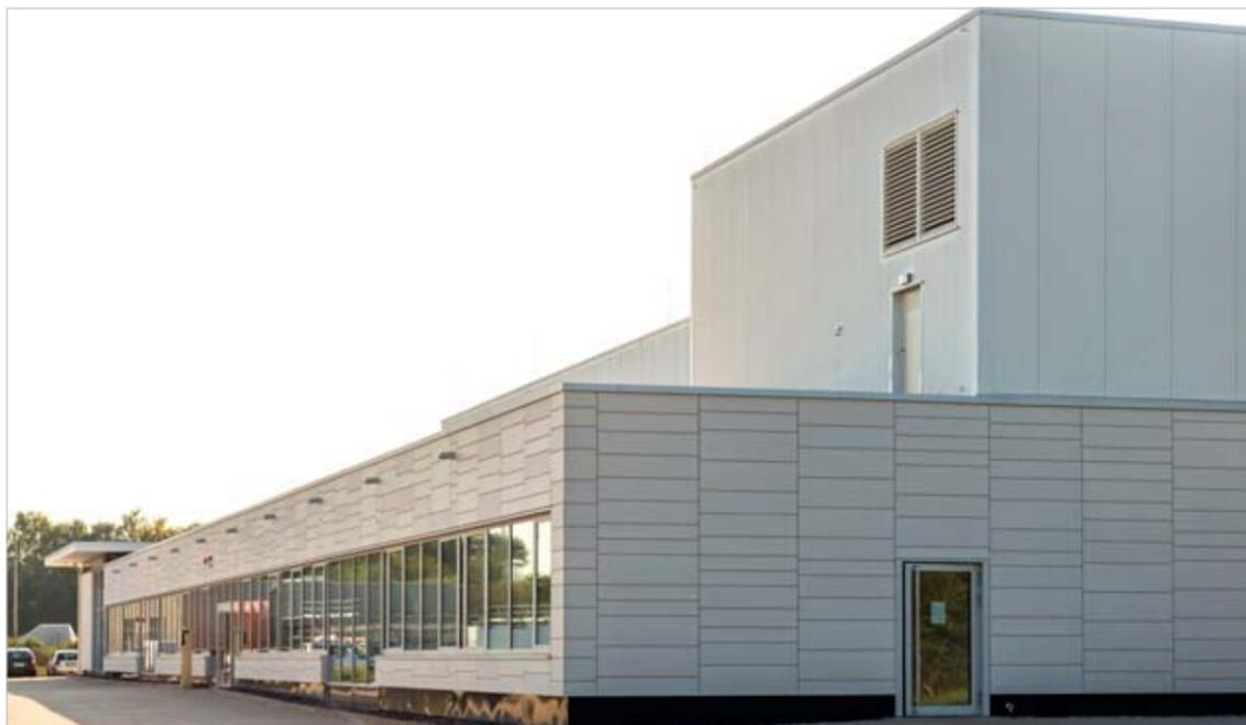
Für die neue Fassade wurde das Fassadensystem Argeton von Wienerberger verwendet. Die im Strangpressverfahren hergestellten Fassadenelemente bieten eine hohe statische Festigkeit sowie eine Witterungs- und Frostbeständigkeit.
