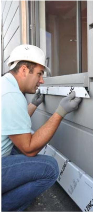
Das einfach zu installierende System umfasst sechs unterschiedliche Profilvarianten aus Titanzink.
