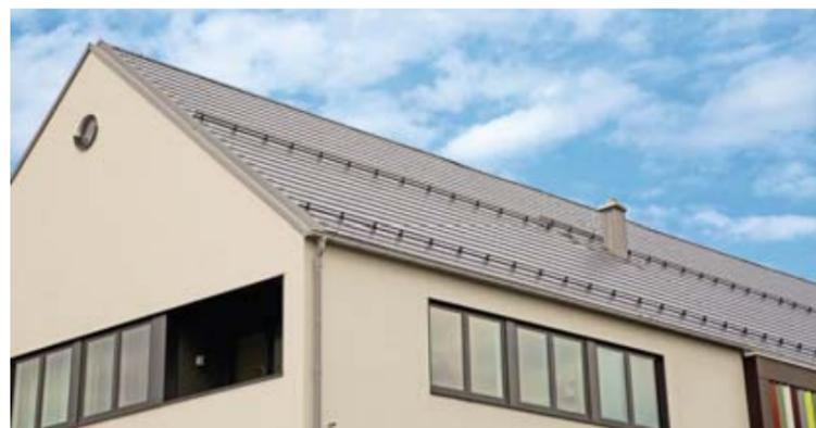
Das Steildach leitet aufgrund der Dachschräge Wasser ab und Schnee rutscht in die dafür vorgesehenen Schneeschutz-Vorrichtungen. Zudem ermöglicht die Schräge eine einfachere Nutzung von Solarenergie.
