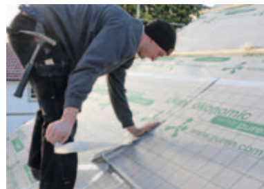
Luftdichte Verklebung der Plattenquerstöße durch „Kleber-auf-Kleber-System“
