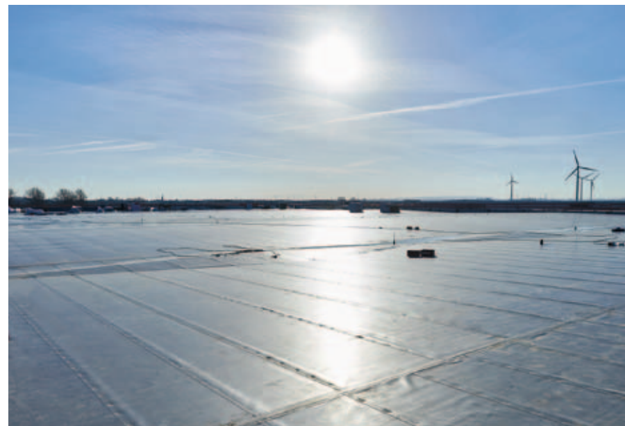
Rhepanol® hfk ist in wirtschaftlichen Bahnenbreiten von bis zu 1,50 m erhältlich. Fotos: FDT/Sven-Erik Tornow
