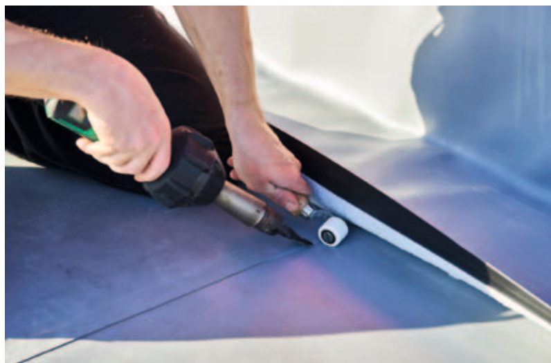
Gefügt werden die Rhepanol® Dachbahnen mittels Heißluft. Hierzu ist der Schweißbrand der vlieskaschierten Dachbahnen vliesfrei.
