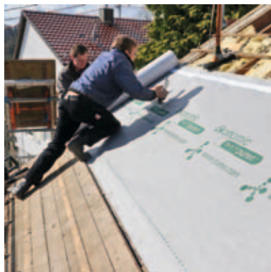
Die Luftdichtung wird mit der speziellen Sanierungsdampfbremse sichergestellt.
