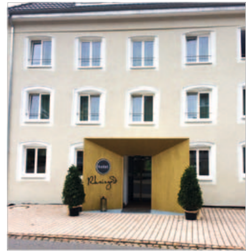
Der aus Brettschichtholz konstruierte Eingangsbereich ist Blickfang, Vorbau und Vordach zugleich. Seine Oberfläche besteht aus einer Enkopur-Abdichtung mit Vlieseinlage und Nahtband – zur Farbgestaltung kam das Beschichtungssystem Enke-Multi-Protect zum Einsatz.
