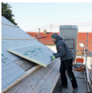
Mit Nut-Feder-System ausgerüstet lassen sich die ökonomisch-Dämmplatten wärmebrückenfrei verlegen.
