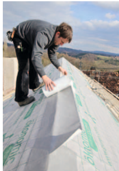
Perfekter Abschluss am First mit dem First-/Gratband puren Diffucell.
