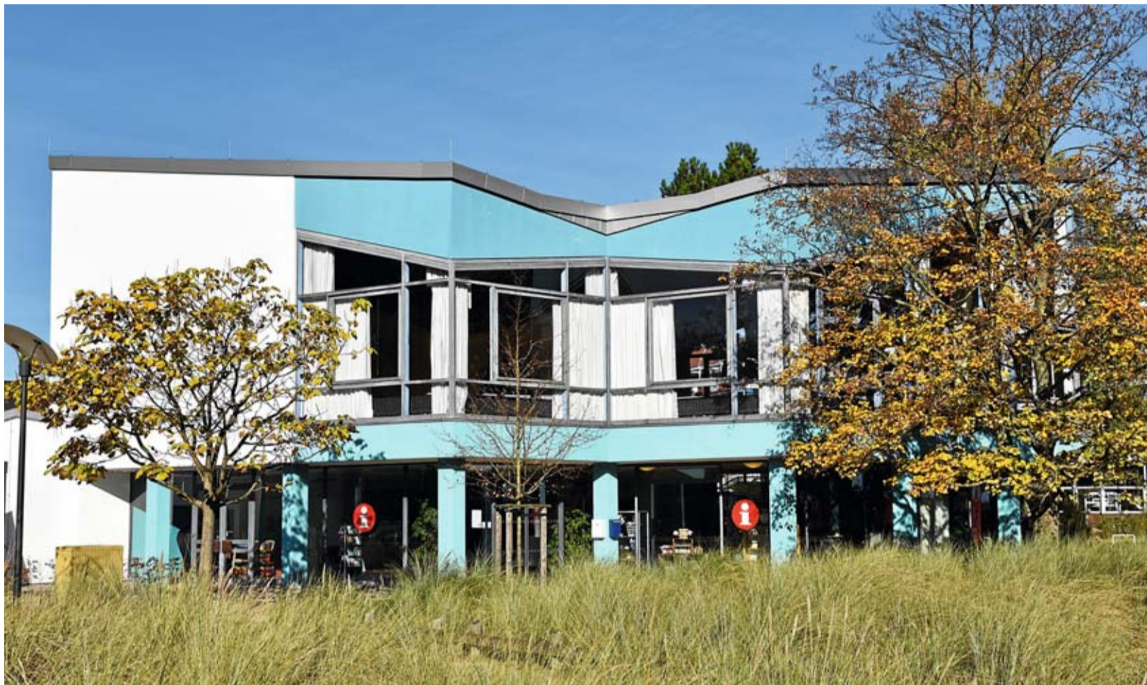
Der Saal des Kurparkhauses in Scharbeutz an der Ostsee zeigt sich mit einem neuen Flachdach, das von der Gebr. Behrend Dachtechnik GmbH grundsaniert und energetisch in Stand gesetzt wurde.
