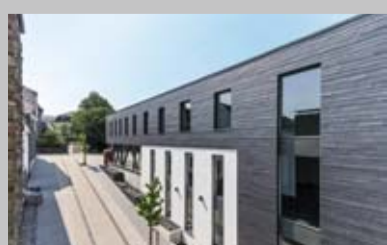
Für das zeitgemäße Design sorgt die Dynamische Schieferdeckung von Rathscheck Schiefer.
