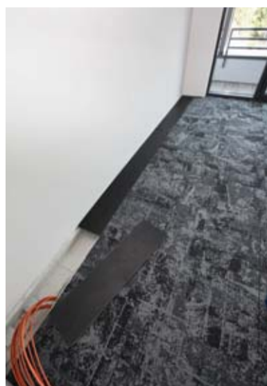
Preiswerte Schieferwerksteine als Abdeckung für Kabelkanäle.
