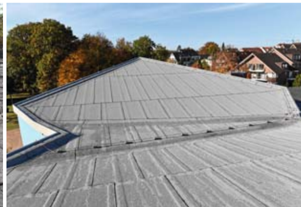
Mehrere Schichten 500er Bitumenpappe, Korkplatten und diverse Schichten vorangegangener Sanierungsversuche lagen zusammen mit der alten Dampfsperre- und Dampfdruckausgleichsschicht auf dem 50 Jahre alten sanierungsbedürftigen Flachdach (links). Nach der Sanierung präsentiert sich das neue Flachdach mit einer Oberlage aus plasto-elastischen Polymerbitumenschweißbahn und oberseitigem Schiefersplitt in einem Melangeton (oben).
