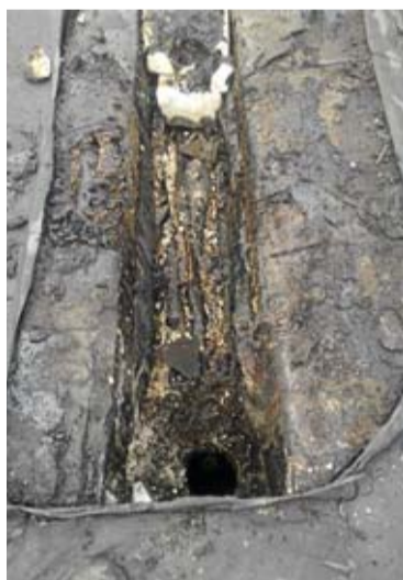
Mehrere Schichten 500er Bitumenpappe, Korkplatten und diverse Schichten vorangegangener Sanierungsversuche lagen zusammen mit der alten Dampfsperre- und Dampfdruckausgleichsschicht auf dem 50 Jahre alten sanierungsbedürftigen Flachdach (links). Nach der Sanierung präsentiert sich das neue Flachdach mit einer Oberlage aus plasto-elastischen Polymerbitumenschweißbahn und oberseitigem Schiefersplitt in einem Melangeton (oben).
