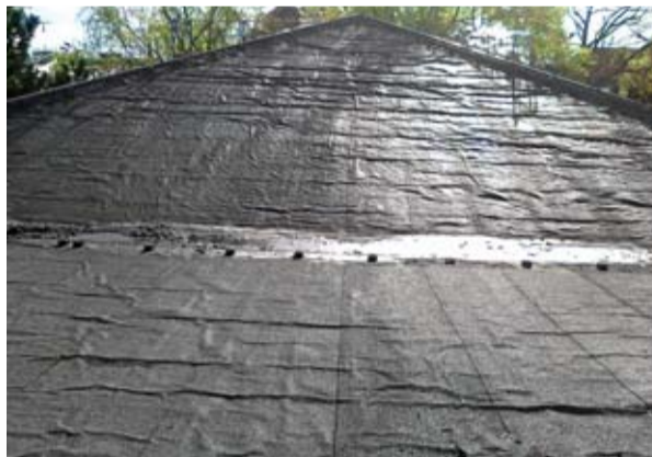
Mehrere Schichten 500er Bitumenpappe, Korkplatten und diverse Schichten vorangegangener Sanierungsversuche lagen zusammen mit der alten Dampfsperre- und Dampfdruckausgleichsschicht auf dem 50 Jahre alten sanierungsbedürftigen Flachdach (links). Nach der Sanierung präsentiert sich das neue Flachdach mit einer Oberlage aus plasto-elastischen Polymerbitumenschweißbahn und oberseitigem Schiefersplitt in einem Melangeton (oben).
