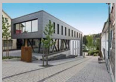
Die Fensterbreiten in der Längsseite der Fassade skalieren in der Breite von 0,6 bis 1,51 Metern. Von der Straße aus gesehen, wirken alle Fenster gleich breit und das Gebäude dadurch optisch verkürzt.
