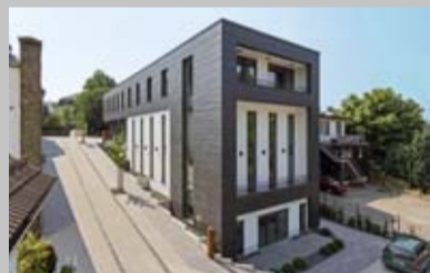
Das viergeschossige Geschäftshaus ist in Schiefer- und Putzflächen unterteilt und damit optisch klein gehalten.
