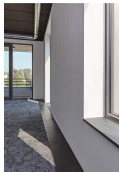
Edle Oberflächen: Fensterbänke und Kabelkanäle aus Schieferwerksteinen.
