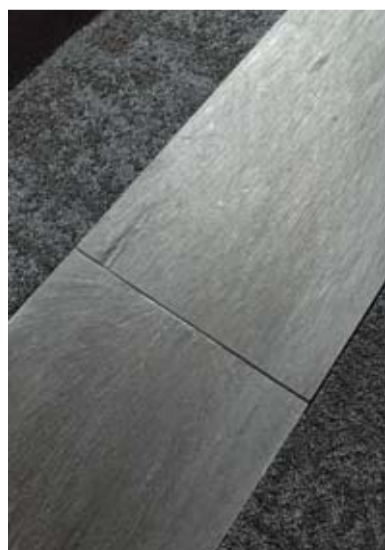
Seidig glänzende Oberflächen der Kabelkanal-Abdeckungen aus Schieferwerksteinen.
