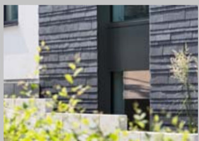
Dynamische Deckung aus Rathscheck Schiefer in den Anschlussbereichen an Fensterzarge oder verputztem WDVS.
