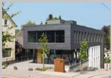
Das von der Straßenfront zurückversetzte Gebäude formt einen kleinen Platz mit Bäumen.
