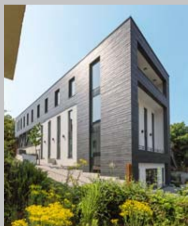
Das viergeschossige Geschäftshaus ist in Schiefer- und Putzflächen unterteilt und damit optisch klein gehalten.
