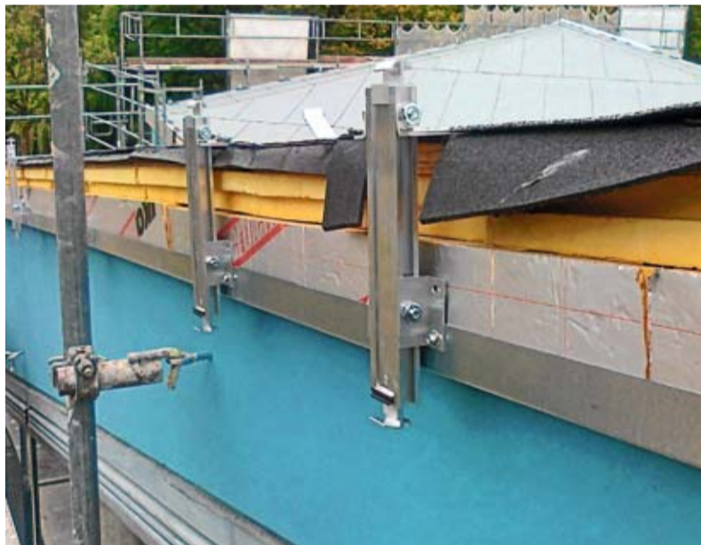
Der Schichtenaufbau nach der Sanierung.
