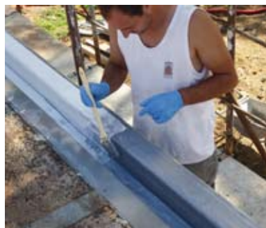
Dachrandabdichtung mit Polyflexvlies und Enkopur
