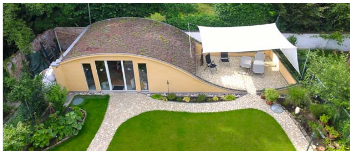
Frank Präders einzigartiges Gartenhaus „Die Welle“ im fertigen Zustand im Juli 2015. Der wellenförmige Verlauf des Gartenhauses schafft eine Einheit von Haus und Sitzplatz. Im Verlauf der Form von Bauwerk zum Boden werden Natur und Haus eins.
