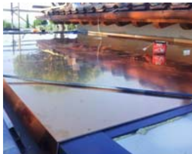
Die Tecu-Bond-Verbundplatten werden direkt mittels Nieten auf den L-Profilen befestigt
