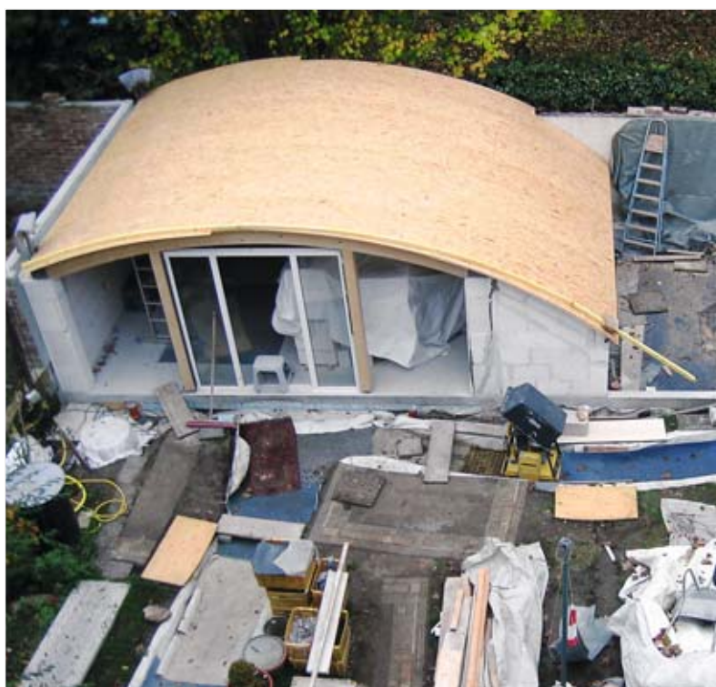
Die zweilagige Dachschalung aus 12 mm OSB3-Platten war bei diesem Projekt eine der größten Herausforderungen. Sie wurde perfekt gemeistert.
