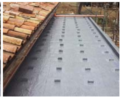
Auf dem Betonuntergrund aufgedübelt L-Konsolen werden mit Polyflexvlies-Manschetten und dem Flüssigkunststoff Enkopur langzeitsicher abgedichtet.
