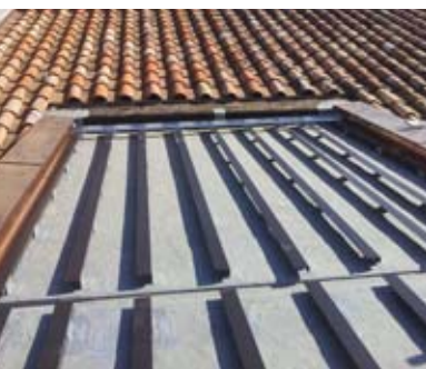
Fluchtgerechte Montage farbbeschichteter L-Profile zur späteren Aufnahme der Kupfer-Verbundplatten
