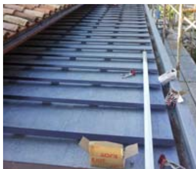
Fluchtgerechte Montage farbbeschichteter L-Profile zur späteren Aufnahme der Kupfer-Verbundplatten
