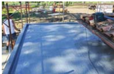
Vollflächig mit Polyflexvlies und Enkopur abgedichtete Betondachfläche
