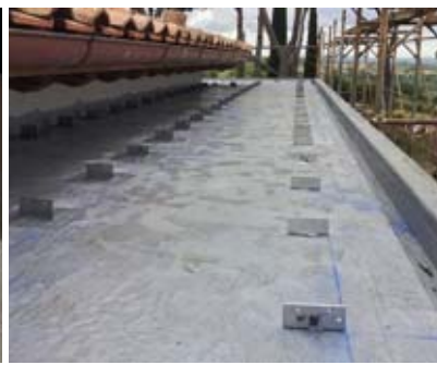
Auf dem Betonuntergrund aufgedübelt L-Konsolen werden mit Polyflexvlies-Manschetten und dem Flüssigkunststoff Enkopur langzeitsicher abgedichtet.
