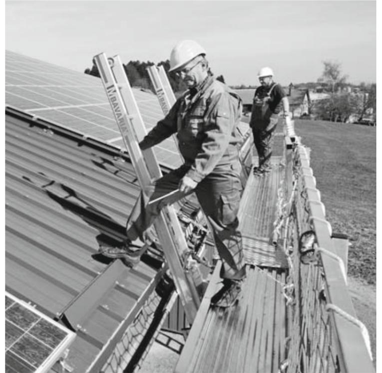
Dachschutzwandhalterungen wie bei üblicher Bauart behindert. Beim BAVARIA-Blitzgerüst SL wird die komplette Absturzsicherung am Boden aufgebaut und ohne Absturzgefahr über Winden blitzschnell auf die gewünschte Arbeitshöhe gebracht. Mehr noch: Alle BAVARIA-Absturzsicherungen sind mit den bewährten BAVARIA-Leitern und lassen sich problemlos nachrüsten.
