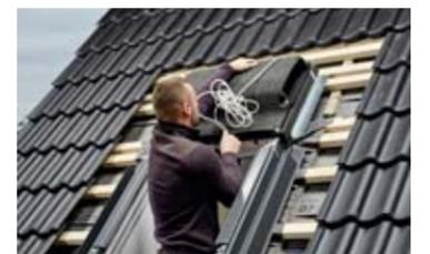
Die Installation von Velux Smart Ventilation ist einfach: der Fensterlüfter wird anstelle des Standard-Markisenkastens über das Dachfenster gesetzt.
