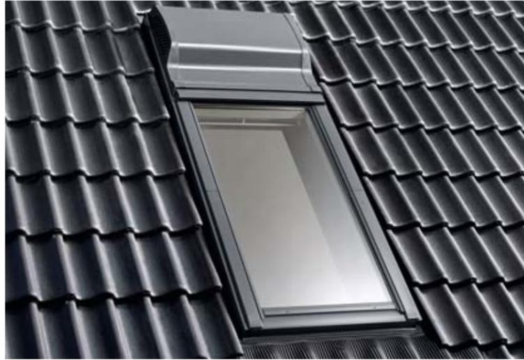
Velux Smart Ventilation, der erste Lüfter mit Wärmerückgewinnung für Dachfenster, wird anstelle des Standard-Markisenkastens oberhalb des Dachfensters montiert.
