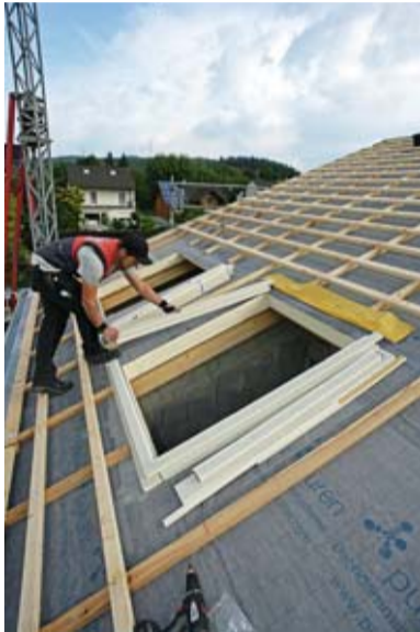
Die Einzelteile der Dämmzargen werden rund um die vorbereiteten Fensteröffnungen ausgelegt und verschraubt.
