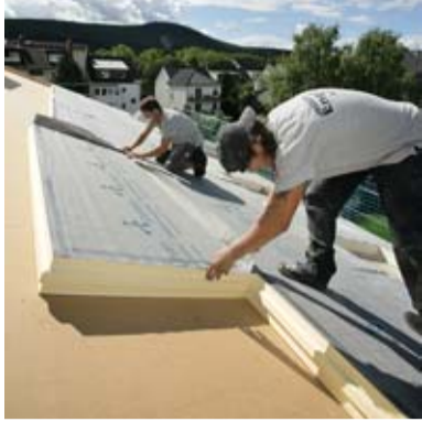
Schnelle und passgenaue Verlegung der Steildachdämmung.
