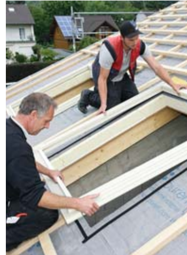
Die Dämmzargen werden auf die Kompribänder gelegt und mit der Dachkonstruktion verschraubt.
