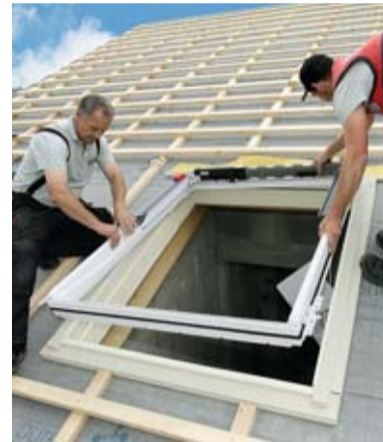
Einbau des mit Kompribändern gestückten Fensterrahmens in die Dämmzarge.
