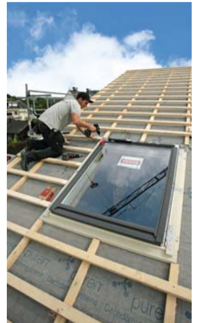
Dachlattenmontage auf der Dämmzarge. Fotos: puren
