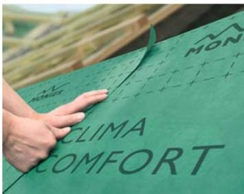
*Braas Clima Comfort: Die Unterdeckbahn mit integrierter Doppelklebezone ist bereits auf die Dämmelemente aufkaschiert.*
