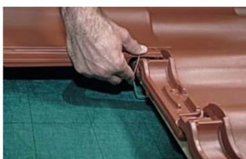
Der Rubin 15V ist das erste Dachziegelmodell, für das der Braas Clip, die neue, werkzeugfrei zu verlegende Sturmklammer, erhältlich ist.
