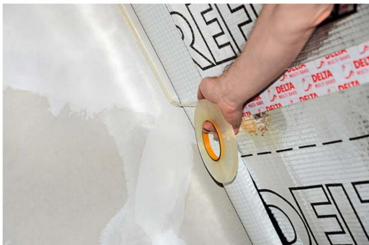
Eine besonders sichere und rationelle Lösung für den wind- und luftdichten Anschluss von Unterdeck- und Fassadenbahnen sowie Luft- und Dampfsperren an aufgehende Bauteile ist die „Dichtschnur von der Rolle“ Delta-Tixx VDR. Die dauerelastische lösemittelfreie Hochleistungsklebermasse wird lückenlos von der Rolle auf dem Untergrund angedrückt und die Bahn wird spannungsfrei auf die acht Millimeter breite Klebeschnur gepresst.
