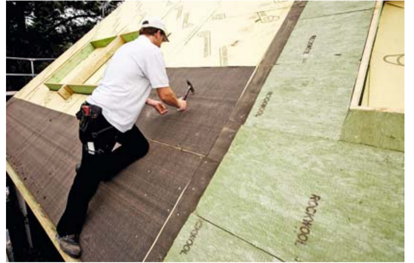
Eine zusätzliche Bitumenbahn unter der 18 cm dicken Aufsparrendämmung mit Masterrock von ROCKWOOL sorgte für zusätzliche Dachmasse.
