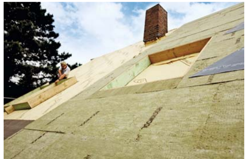
Zuvor exakt angepasste Holzrahmen bildeten die Basis für den Einbau von zwei- und viergliedrigen Schallschutzfenstern.
