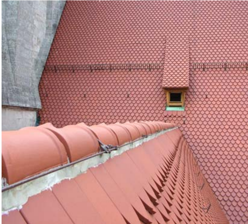
Als bisher einziger Dachziegel konnte der 23 mm starke Sinterbiber der ERLUS AG, der für die neugotische Pfarrkirche St. Paul in München hergestellt wurde, die Hagelwiderstandsklasse 5+ erzielen.
