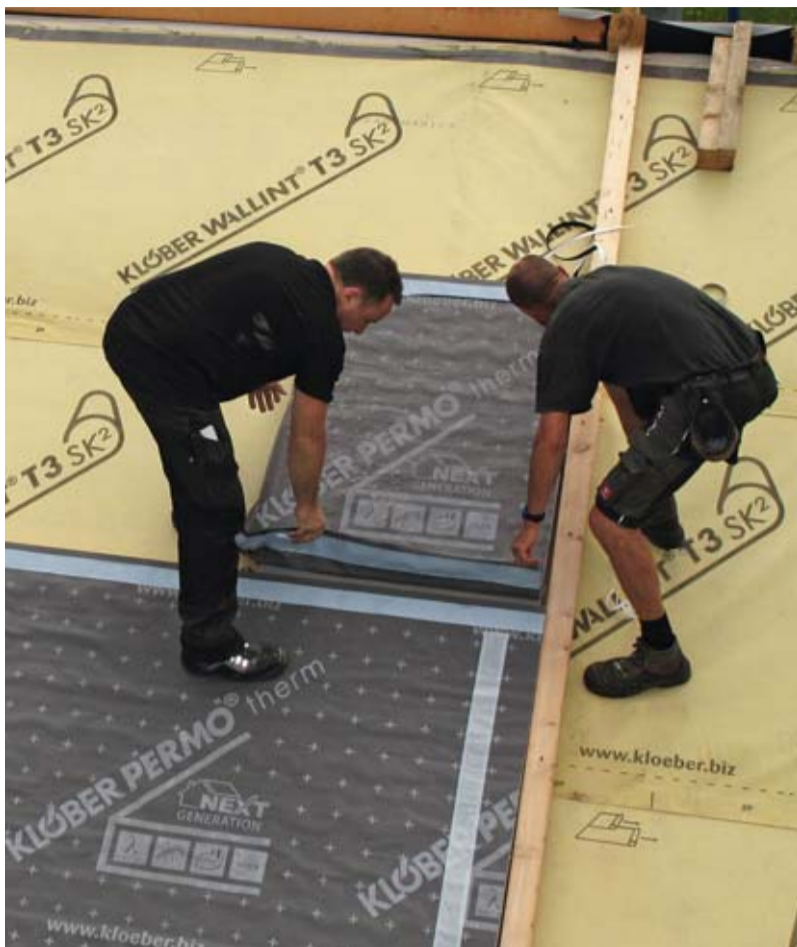
Das Klöber Aufdach-Dämmsystem Permo ® therm besticht durch optimierte Dämmwerte.
