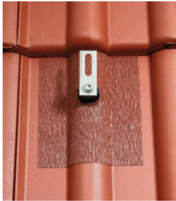
Alternativ kann der Solarhalter auf der Dachpfanne auch mit der Easy-Form® Uniplus Dichtmanschette mit vollflächiger, unterseitiger Butylbeschichtung sicher abgedeckt werden.
