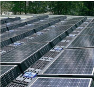
Das leichte Photovoltaik-System SOLfixx plus der Stuttgarter Paul Bauder GmbH & Co. KG eignet sich für fast jedes Flachdach und lässt sich einfach und werkzeuglos vom Dachdecker auf der Oberlage verschweißen.
