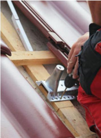
Die Befestigung des Venduct® Uniplus Solarhalter erfolgt auf dem Sparren. Dabei erleichtert das optimierte Lochbild die Positionierung.
