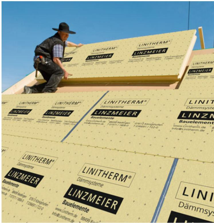
LINITHERM PAL N+F die sichere Dämmung für Dachneigungen ab 20 Grad ist Wärmedämmung, Unterdeckung, geeignet als Behelfsdeckung und bietet Schutz vor Elektromog
