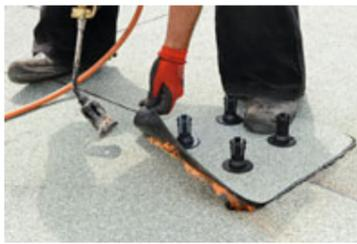
Das leichte Photovoltaik-System SOLfixx plus der Stuttgarter Paul Bauder GmbH & Co. KG eignet sich für fast jedes Flachdach und lässt sich einfach und werkzeuglos vom Dachdecker auf der Oberlage verschweißen.
