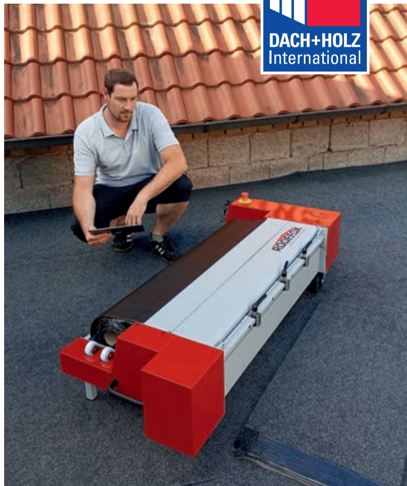
Schneide-Fuchs fürs Flachdach von Dachdecker Tobias Büttgen.
