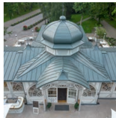
Architekt: Andis Kalniņš; Cēsis, Lettland, Handwerker: SIA „SK Lauktehnika“, Grobiņa, Lettland.
