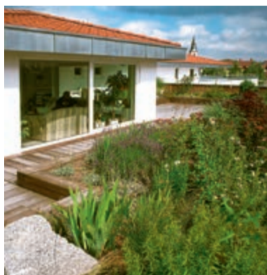
Intensivbegrünung auf einem genutzten Flachdach. © Foto: Bauder
