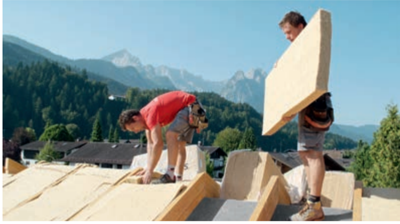
Eine 200 mm starke Zwischensparrendämmung mit der Holzfaser-Dämmmatte STEICOflex 036 sorgt für einen GEG-konformen U-Wert und schützt den Dachraum im Sommer vor Überhitzung. © Foto: STEICO
