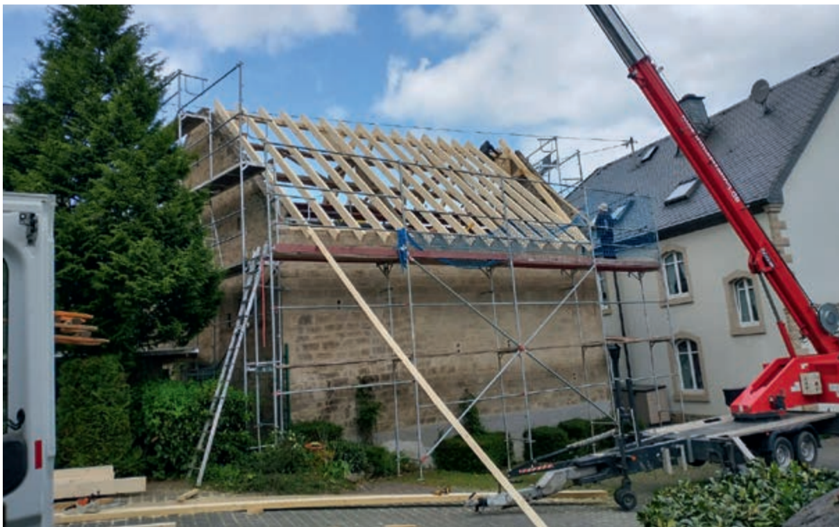
Nach der Abtragung des alten Dachmaterials folgte der Aufbau des neuen Dachstuhls.
