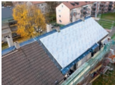
Das Sanierungskonzept des Zimmerermeisters Johannes Frey sah den Rückbau bis zu den Sparren sowie eine Aufsparrendämmung mit einem PU-Hochleistungsdämmstoff und einer anschließenden Neudeckung mit Dachsteinen vor.
