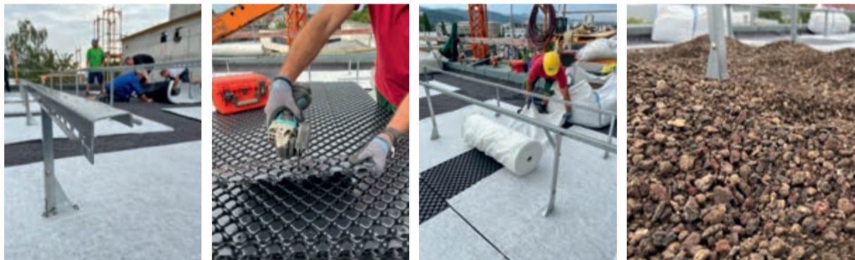
In den Zwischenräumen werden die bei Bedarf zugeschnittenen Speicherelement-Platten aus dem SOPREMA Gründachsystem und das Filtervlies verlegt. Danach wird das Substrat aufgeschüttet; es dient gleichzeitig als Ballastierung für das PV-System.
