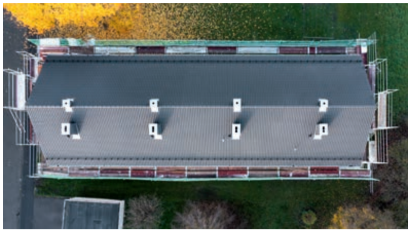
Für ein Gebäude benötigten die Fachhandwerker der Frey Holzbau & Bedachungen GmbH knapp dreieinhalb Wochen, um das 380 Quadratmeter große Satteldach komplett zu sanieren.
