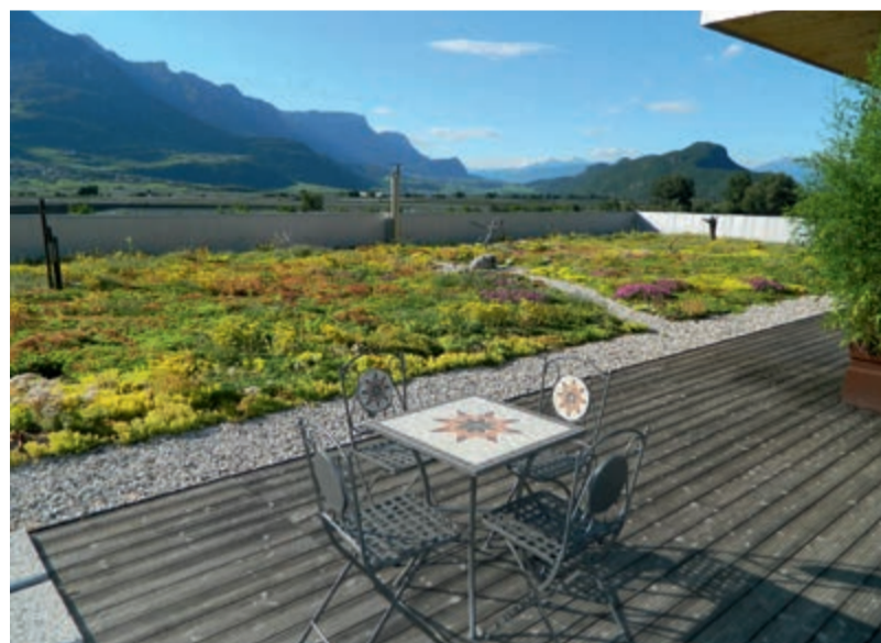
Extensive Dachbegrünung auf einem Industriedach. © Fotos: Bauder
