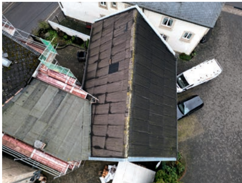
Die Drohnenaufnahme ermöglicht die Sicht auf das Vorher-Nachher-Bild mit perfektem Ergebnis: Das neue Scheunendach mit dem innovativen Rathscheck Schiefer System. Hier dominieren klare Strukturen mit flachen, flächenbündig verlegten PV-Modulen.
