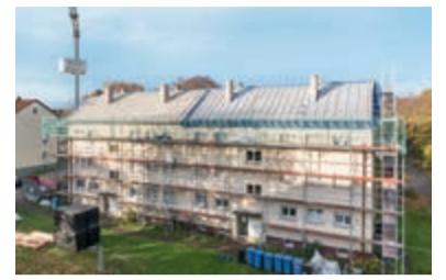
Innerhalb weniger Tage konnte die Aufsparrendämmung auf den insgesamt 380 Quadratmeter großen Satteldächern verlegt werden.
