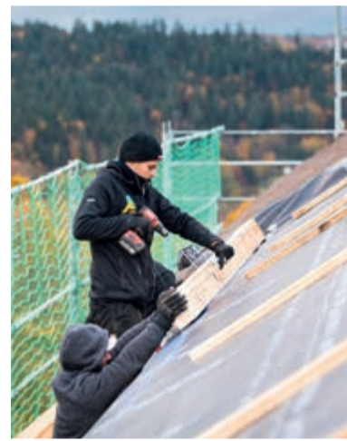
Im Traufbereich sorgen auf die Tragkonstruktion montierte Anschlaghölzer für die Begrenzung der Dämmschicht.
