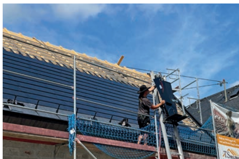
Die Dachdecker- und Zimmerermeister der TS HOLZBAU aus Niederzissen nutzten das innovative Montagesystem von Rathscheck, um die vorgefertigten Schiefer-Solar-Module zu fixieren. Dabei kam eine patentierte Systemlösung aus Tragprofilen und wasserführenden Verbindungselementen zum Einsatz, die hocheffizient ist und Material spart.
