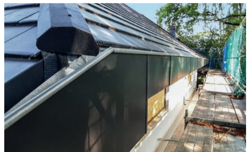
An die matt-schwarzen Dachsteine und die schwarzen PV-Module wurden auch die Dachrinnelemente farblich optimal angepasst. Erreicht wurde dies mit einer anthrazitfarbenen eingefassten Dachrinne VM-ANTHRA-ZINC®.
