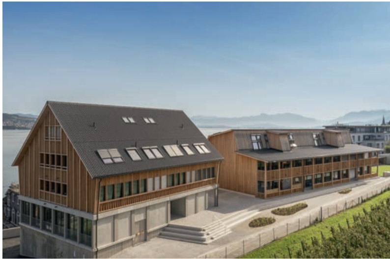
Nachhaltig, nicht brennbar, witterungsbeständig: Faserzement-Wellplatten von Swisspearl auf dem Dach eines Studentenwohnheimes im schweizerischen Wädilschwil.
