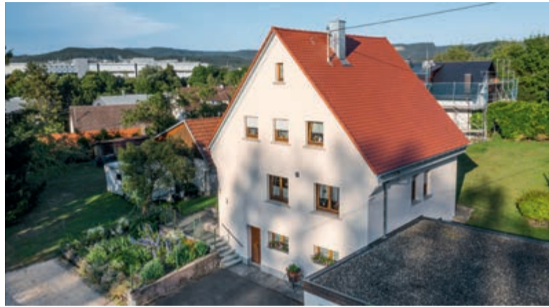
Ohne große Beeinträchtigung der darunterliegenden Wohnräume konnte das Einfamilienhaus wirksam gedämmt und neu gedeckt werden.
