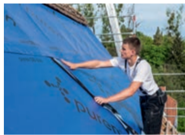
Das „Kleber-auf-Kleber-System“ sorgt nicht nur für die luftdichte Verbindung der Bahnen untereinander, sondern verhindert auch Feuchtwanderung durch Kapillare.
