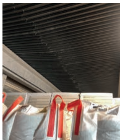
Flachdachhalle: Oben Schnee, unten Knick.
