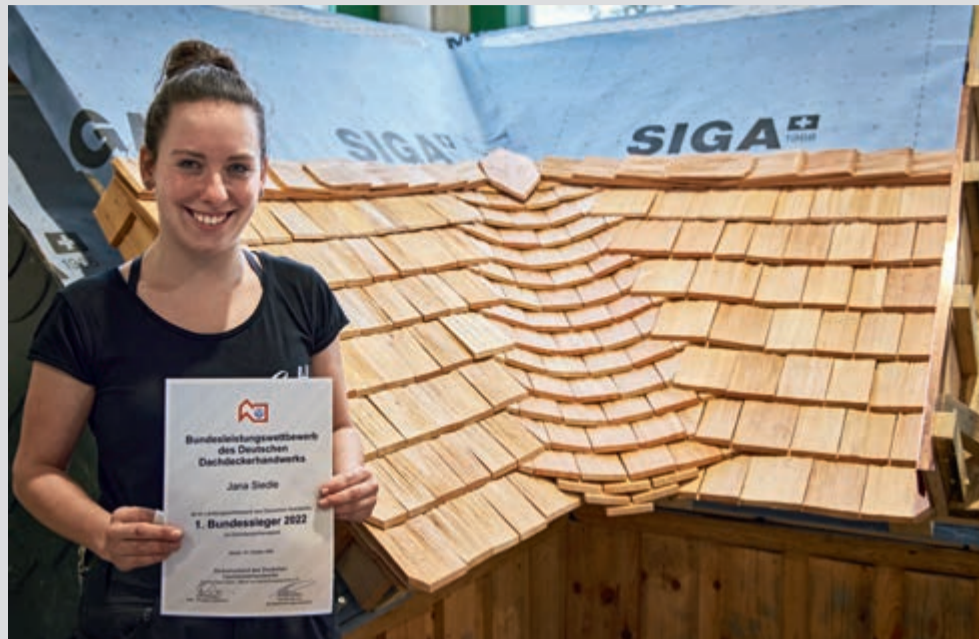
Hauptarbeitsprobe der besten Dachdeckerin Jana Siedle: Holzschindeleindeckung mit eingebundener Hauptkehle. © Fotos: Laura A. Herzmann
