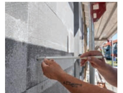
Dank der Cedral Click Klammer lassen sich die langlebigen Faserzementpaneele schnell und einfach montieren.
