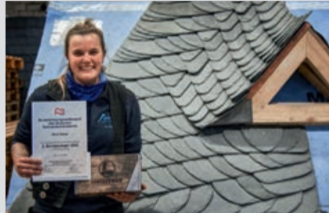
Hauptarbeitsprobe Nina Weber: Linke Sattelkehle an einer Spitzgaube mit Schwärmern, eingebunden in Altdeutscher Deckung
