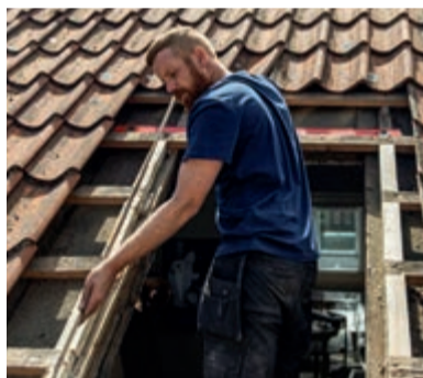
Die Erweiterung der Fensterfläche beim Austausch eines alten Dachfensters wird bei den in der Vergangenheit häufig verbauten Modellen mit der Breite 66 cm durch das neue Unterelement deutlich einfacher.
