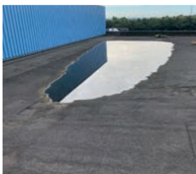
Wo das Flachdach eingeknickt ist, hat sich nach der Schneeschmelze ein „See“ gebildet. Das aufgehende Bauteil hat vermutlich an dieser Stelle zu einer durch Verwehungen erhöhten Schneelast geführt.
