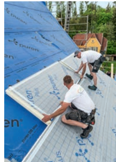
Zur wärmebrückenfreien Verlegung werden die Dämmplatten mittels Nut und Feder ineinandergeschoben.
