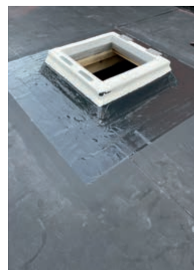
Komplettabdichtung eines Lichtkuppel-Aufsetzkranzes, ebenfalls ohne zusätzliche oberseitige Verwahrung.
