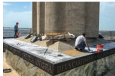
Bereits 2017 erfolgte die Abdichtung geradlinig verlaufender Sockelbereiche mit Enkopur ® Flüssigkunststoff.
