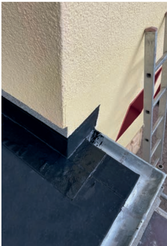
Ausführung eines Wandanschlusses mit integrierter Eckausbildung, ohne oberseitige Verwahrung.
