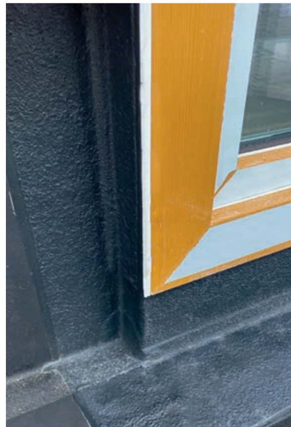
Der fertiggestellte Anschluss im Fensterbereich passt sich farblich der angrenzenden RESITRIX® Abdichtung perfekt an.
