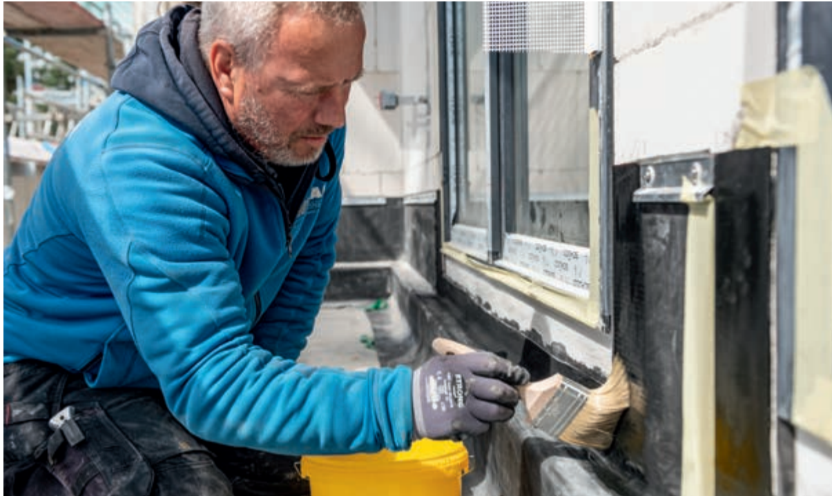
Auftrag des LIQUISEAL Primers auf die angrenzende RESITRIX® EPDM-Abdichtung.
