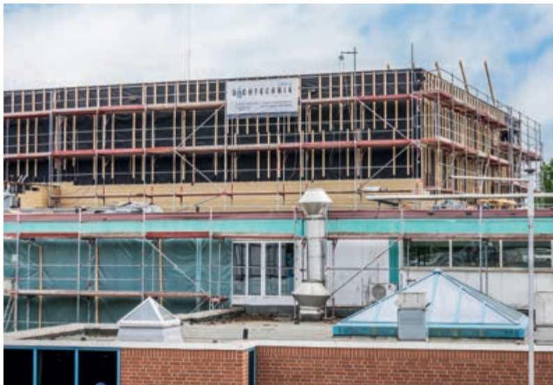
Die Sanierung des Celler Badelands beinhaltet unter anderem die Erneuerung der Außenhülle als wärmebrückenfreien Cedral Fassade.
