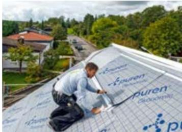
Oberseitig sind die Dämmplatten mit der diffusionsoffenen Unterdachbahn Diffucell kaschirt. Zur dauerhaft winddichten und kapillarfreien Verklebung der Unterdachbahnen untereinander, wird das „Kleber-auf-Kleber“-System im überlappenden Nahtbereich genutzt.
