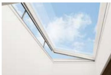
Auch die drei neuen Größen sind als öffnbare Varianten erhältlich. Die Ausführungen 150x150 cm und 200x100 cm werden durch einen zusätzlichen zweiten in das Basiselement integrierten Motor geöffnet.
