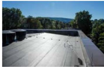
Altes Industriedach mit der schwarzen Sanierungsbahn WOLFIN GWSK saniert.
