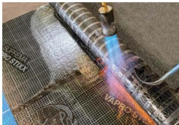
SOPREMA Vapro uno – die eine, die beides kann: Die Hochwertoberlage lässt sich hervorragend vollflächig verschweißen (li.) und kann im einlagigen Aufbau durch Aktivierung der Thermstreifen auch nur teilweise verschweißt werden (re.). Weitere Verarbeitungstechniken sind möglich.
