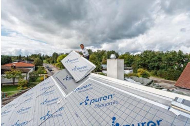
Basis des effizienten Systems ist die hochwirksame PU-Hartschaumplatte puren Ökonic mit umlaufender Nut und Feder-Verbindung. © Fotos: PUREN
