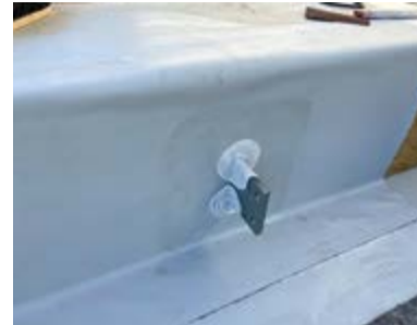
3. Die Polyflexvlies-Außenecken werden vorbereitet.
