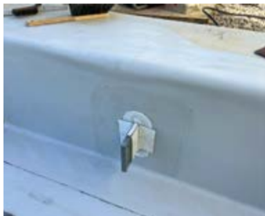
4. Anpassung der Polyflexvlies-Ummantelungen.
