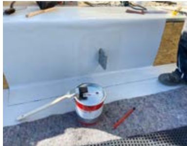
2. Anschliff der Folienbahn mit 40er Korn und Auftrag des Enke-Universalprimer 2K.
