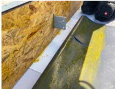
1. Vorbereitung der Unterkonstruktion und Auftrag des Folienklebers.
