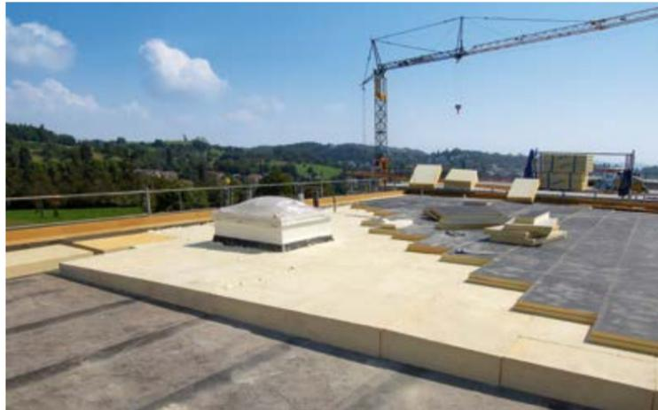
Die PU-Dämmung Secure mit der Einstufung als B-s1, d0 deckt die Gefälledämmung ab und schafft auf diese Weise nach EN 13501-1 eine schwer entflammbare Dachkonstruktion.
