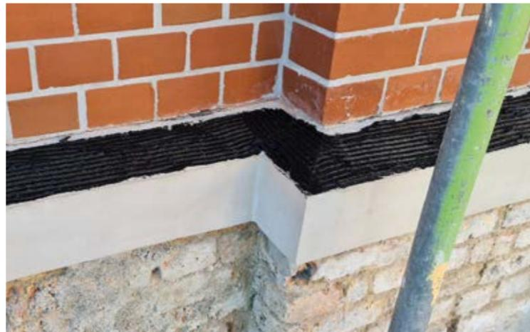
Der bituminöse Blechkaltkleber Enkolit® zeichnet sich durch eine ganze Reihe unerreichter Vorteile aus und das seit über 50 Jahren. Zu den bedeutendsten Pluspunkten zählen der Korrosionsschutz sowie die enorme Sturmsicherheit durch die vollflächige Verklebung.
