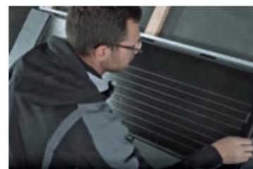
Leichte Integration eines Photovoltaik-Elementes in das Rathscheck Schiefer-System.
