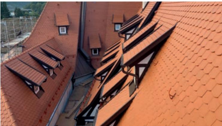
Vorher wie nachher echt steil. In das bis zu 67° geneigte Dach mit einer Fläche von 950 m<sup>2</sup> brachten die 38 Gauben wertvolles Licht und die Möglichkeit zum Luftaustausch.
