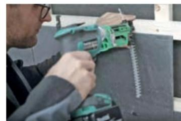
Montage der Edelstahl-Spezialhaken für die Horizontale Deckung.
