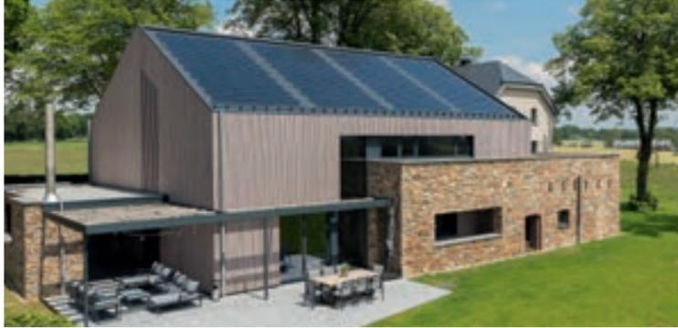
Auf der Südseite trägt das Schieferdach 120 Solarmodule. Damit ist das Bauwerk weitgehend energieautark.
