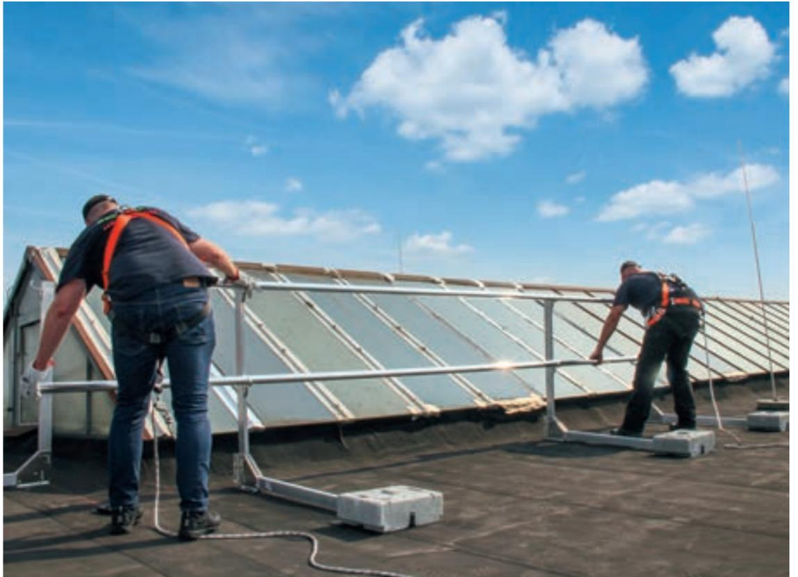
Das GUARD Seitenschutzsystem von CARLISLE® ist besonders einfach und schnell zu montieren und auf allen gängigen Untergründen im Flachdach aufstellbar.
