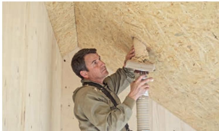
chen an und verdichtet sich zur Holzfaser-Dämmmatte. Dabei spielt es keine Rolle, ob die Gefache auf gängige Dämmstoffgrößen abgestimmt sind. Auch Installationselemente in den Gefachen werden beim Einblasen ohne langwierige Handarbeit exakt umschlossen. Selbst bei kniffligen Konstruktionen wird eine homogene, fugenfreie und dauerhaft sichere Füllung erreicht.
