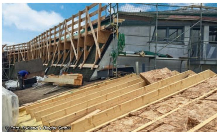
Viele Dachbereiche mussten individuell gesichert werden. Dazu konstruierte die Zimmererfirma Rinn ein individuelles System als Holzkonstruktion. Im Vordergrund ist der neue Aufbau bis zur ergänzten, 200 mm dicken Dämmung sichtbar.
