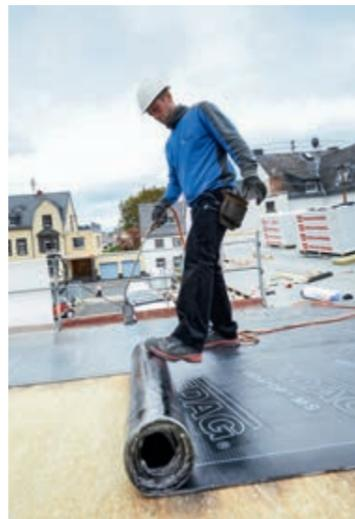
*Dank der besonders klebefreundlichen Oberfläche der „Bitrock“ können Mineralwolle-Unterlagsbahnen direkt auf die Dämmung geschweißt werden. Die Verarbeitung ist dabei so einfach, dass Fehler weitgehend ausgeschlossen sind. Der Markt bietet verschiedene für Mineralwolle geeignete Unterlagsbahnen mit Herstellerfreigabe, die direkt auf der „Bitrock“ aufgeschweißt werden können.* © Fotos: Deutsche Rockwool
