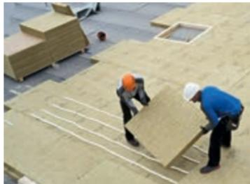
Um den Wärmeschutz weiter zu verbessern und zugleich ideale Voraussetzungen für die sichere Verklebung der Dachabdichtung zu schaffen, wurde eine zweite, ebenfalls 100 mm dicke Lage mit „Bitrock“ Dämmstoffplatten auf der Grunddämmung verlegt.
