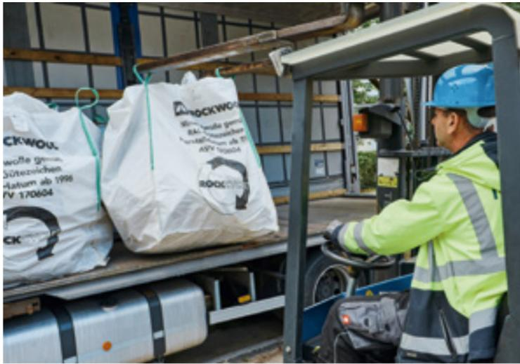
Dieselben Lkw, die neue Dämmplatten für die Verarbeitung bringen, fahren Steinwolle-Verschnitt von der Baustelle zurück in das nächstgelegene Werk der DEUTSCHEN ROCKWOOL. © Fotos: ROCKWOOL
