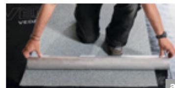
Turbo TO im Lagenversatz zur Unterlage ausrichten, straff auf den Wickelkern aufrollen und bis ca. zur Bahnenmitte zurückrollen.
