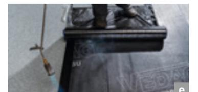
Auf die umgeschlagene Unterseitenfolie stellen, die Längsnaht thermisch aktivieren ...
