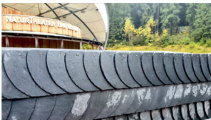
Für die Gefälledämmung auf dem sichelförmigen Dach wurde EPS-Hartschaum Typ PH GLD 100/035 von Philippine verwendet, für die Flachdachabdichtung die EPDM-Dichtungsbahn RESITRIX® SK W Full Bond von Carlisle und für die Bedachung im Eingangsbereich Naturschiefer von Rathscheck.
