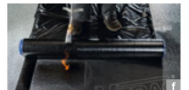
... und dann die Bahn durch gitternetzartiges Aufbrechen der Oberseitenfolie der Unterlagsbahn thermisch aktivieren.
