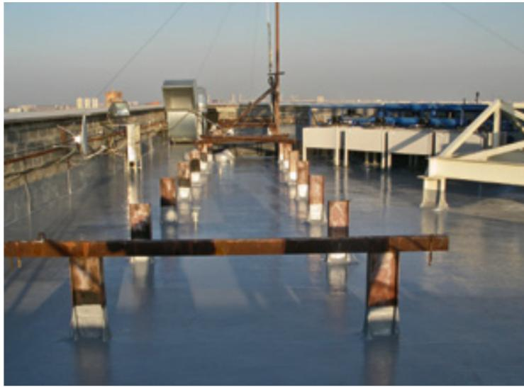
Enkopur weist eine hervorragende Haftung auf bauseits vorkommenden Dachoberflächen auf. Durch die Verwendung von speziellen PUR-Prepolymeren wird eine ausgezeichnete Witterungs- sowie Alterungsbeständigkeit erzielt.
