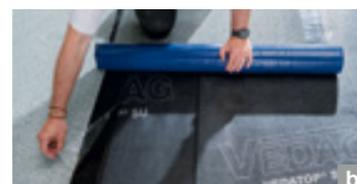
Ab zweiter Bahn: Längsrandstreifen in Richtung der Bestreung lösen und abziehen.
