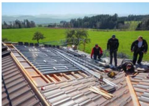
Nachdem die Anker gesetzt wurden, können die Schienen montiert werden.
