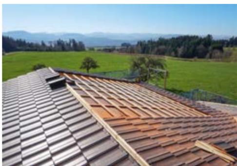
Das Dach ist bereits gedeckt. Nun ist alles bereit für die Installation der dachintegrierten PV-Anlage.
