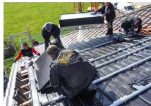
Mit Klemmen werden die Module sicher an der Konstruktion befestigt.
