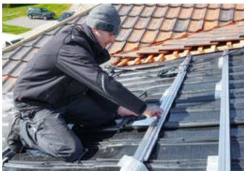
Dann werden die Mikro-Wechselrichter montiert.
