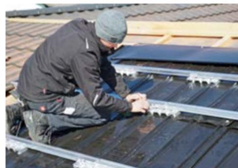
Die Schienen werden montiert und ausgerichtet.
