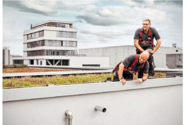
Attikaentwässerung mit Druck: Realisierbar mit dem neuen hochbelastbaren SitaAttika Rohrsystem aus Edelstahl.
