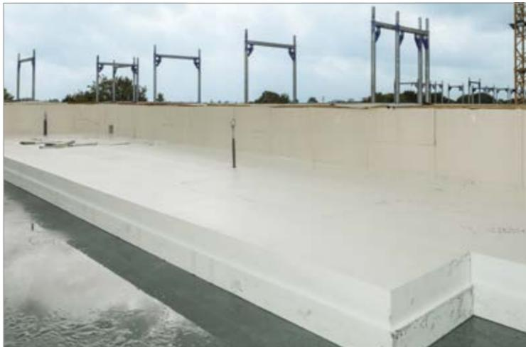
Die Dämmplatten Ursa XPS Twins ermöglichen eine schnelle, einlagige Verlegung mit hohen Dämmstoffdicken. In kürzester Zeit entsteht eine geschlossene und dichte Dämmschicht auf der Abdichtung. © Fotos: Ursa
