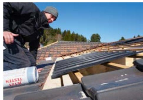
Der traufseitige Anschluss der Intersole wird mit einem Universal-Anschlussband realisiert.
