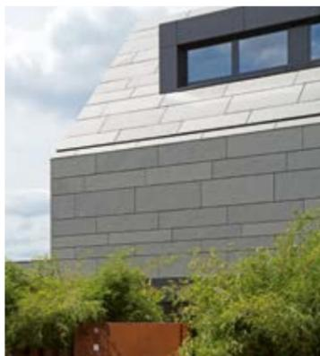
Perfekt: Symmetrische Deckung mit Hinterschnitttechnik.
