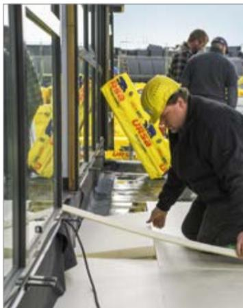
Platten aus extrudiertem Hartschaum (XPS) eignen sich besonders für die Verwendung im Umkehrdach. Der Dämmstoff wird mittels Extrusion hergestellt, die eine Vielzahl kleiner, geschlossener Zellen erzeugt und so für eine hohe mechanische Belastbarkeit und Unempfindlichkeit gegen Feuchtigkeit sorgt.
