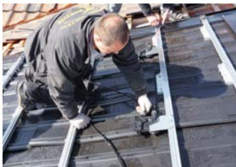
Das AC-Kabel wird eingeklipst.
