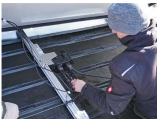
Die PV-Module werden an den Mikro-Wechselrichter angeschlossen.
