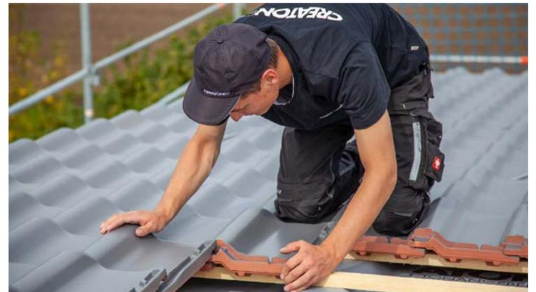
bau eine sichere Grundlage für die Eindeckung des Daches mit Dachziegeln geschaffen. Nach Installation der Traglattung konnte mit der Verlegung der Dachziegel begonnen werden.
