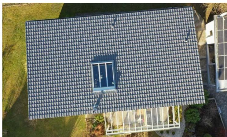
Das Ergebnis kann sich sehen lassen: Rund 171 m<sup>2</sup> wurden mit Systemzubehör und Dachziegeln von Creaton eingedeckt. Unter dem 7°-Dach herrscht nach vier Wochen Sanierungsarbeiten jetzt Ruhe.
