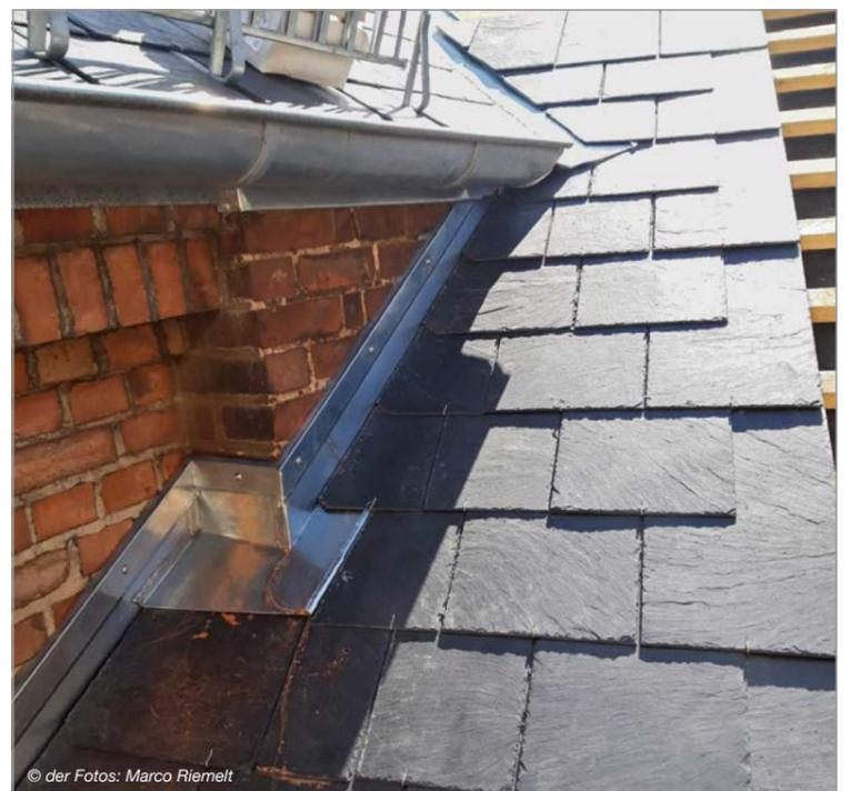
Rund 400 Meter Gesimse und Fensterbleche aus Zink wurden eingebaut. Insgesamt wurden 130 Meter Dachrinnen, 140 Meter Fallrohre angebracht und 20 Tonnen Zinkmaterial verarbeitet. Auch die vielen Dachbekrönungen bestehen aus Zink.
