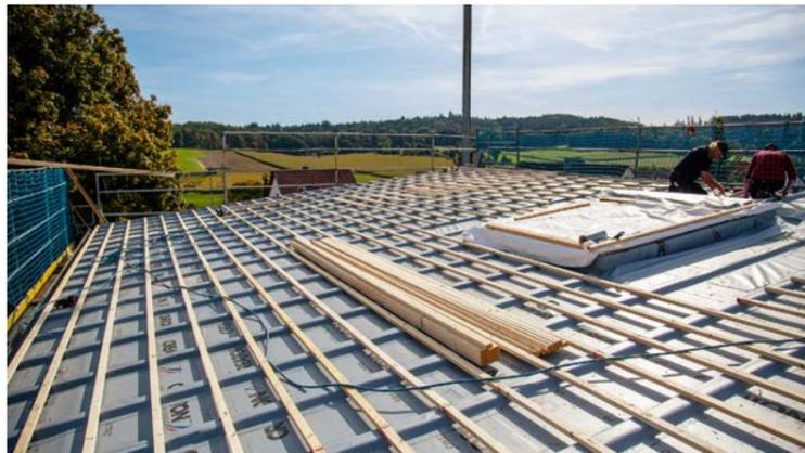
Nach Montage der Traglattung konnte mit der finalen Arbeit – der Verlegung der Dachziegel begonnen werden.
