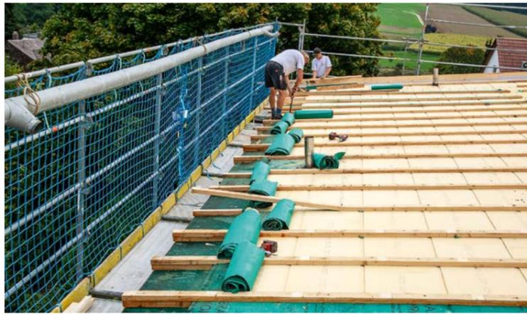
Für eine fachgerechte Neueindeckung mussten – neben der Aluminiumwelle – auch die alten Unterdachbahnen und die alte Konterlattung entfernt werden.
