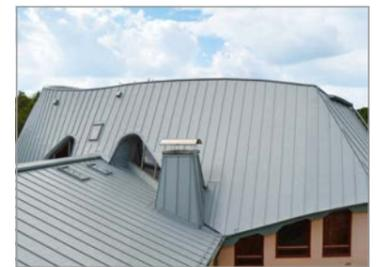
Ausgeführt wurden die Arbeiten in einer attraktiven Doppelstehfalztechnik.
