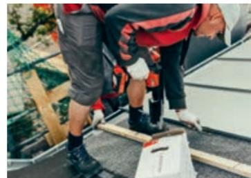
Never change a running system? Nicht bei RHEINZINK – denn es gibt nichts, was man nicht noch besser machen kann. So eben auch das CLIPFIX-System, zur passgenauen Befestigung von Stehfalzprofilen. Es besteht aus dem mit dem Partner FEIN entwickelten CLIPFIX-Magazinschrauber mit Spezialvorsatz, den CLIPFIX-Fest- und Schiebheften aus Edelstahl und passenden CLIPFIX-Schrauben – alles aus einer Hand.
