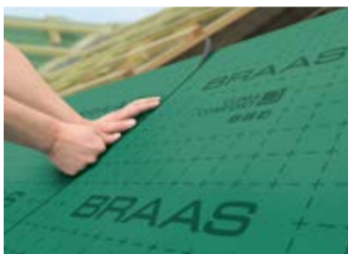
Die Unterdeckbahn mit integriertem Klebestreifen ist bereits auf die Dämmelemente aufkaschiert.
