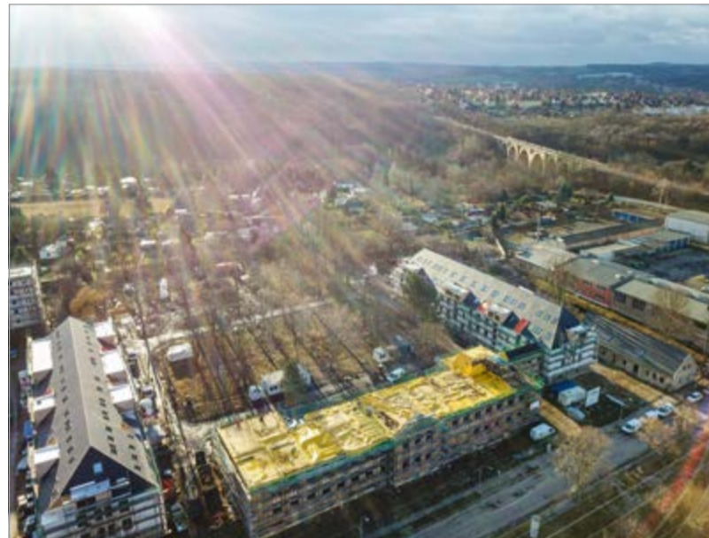
Die Dächer des großen Gebäudekomplexes in U-Form – während der Sanierung durch die Firma „Dächer von Christoph Gruß“.
