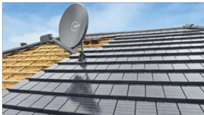
Die Verlegung der Solarziegel unterscheidet sich kaum von einer Standard-Verlegung. Der Dachdecker fügt nur zusätzlich die Steckverbindungen zusammen.
