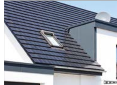
Fast 2.000 Autarq-Solarziegel erzeugen fast unsichtbar den Strom für die Bewohner.
