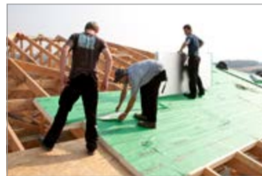
Die vollflächige Verlegung von DivoDämm oberhalb der Sparren verhindert Wärmebrücken.
