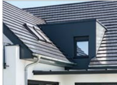
Fast 2.000 Autarq-Solarziegel erzeugen fast unsichtbar den Strom für die Bewohner.
