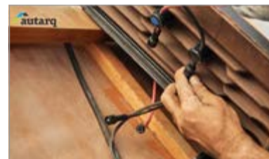
Mit einer Steckverbindung werden die Solarziegel parallel verschaltet wie eine elektrische Christbaumbeleuchtung.
