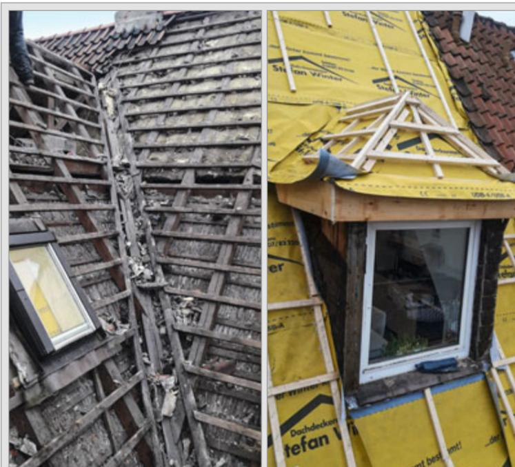
*Zunächst begannen alle mit dem Gerüstbau. Anschließend ging es aufs Dach, denn die alten Ziegel und die alte Dämmung mussten zurückgebaut werden, bevor die Azubis mit der Dämmung der Fläche beginnen konnten.*
