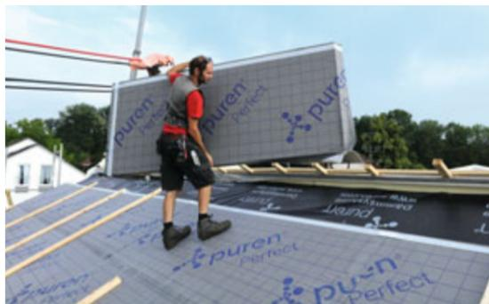
Die Dämmung puren Perfect ist als leichte Einmannplatte konzipiert.
