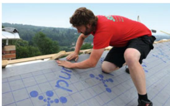
Die Verklebung des Firstes mit dem 300 mm breiten Firstband puren Diffucell ist äußerst robust und haltbar.
