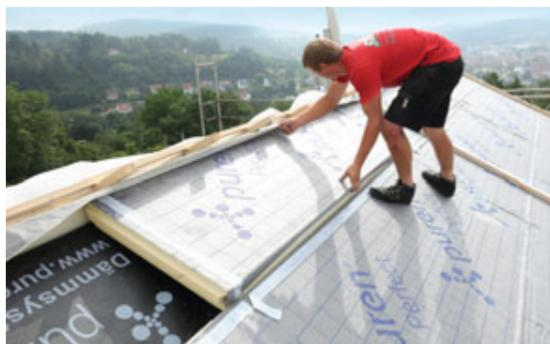
Die Elemente mit den umlaufenden Nut-Feder-Systemen sorgen für einen vollflächigen ungestörten Dämmmantel oberhalb der Sparren.
