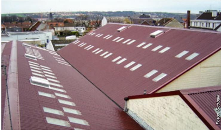
Der entscheidende Vorteil: In den allermeisten Fällen kann die alte Dacheindeckung einfach liegenbleiben, die leichte und montagefreundliche Sanierungslösung wird ohne Bohren direkt auf dem Altdach befestigt. So unkompliziert und effizient geht Dachsanieren heute!
